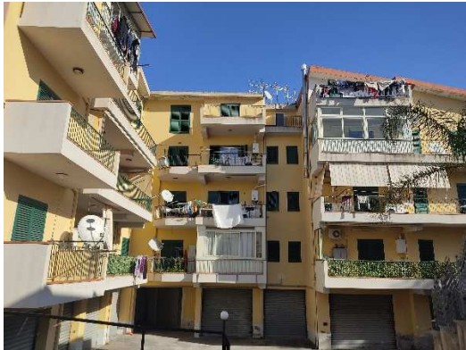
foto n.1 Prospetto Ovest su corte
