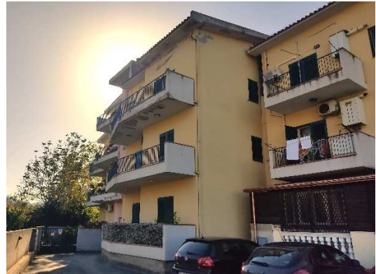
foto n.2 Prospetto Est su corte
