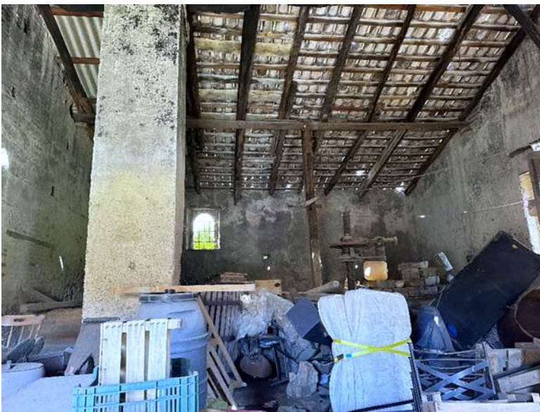
Foto nr. 12 :: particolare della part. sub. 274 – copertura da ripristinare, in quanto fatiscente -
