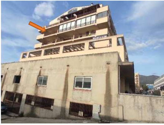
foto n.1 Prospetto Est su corte
