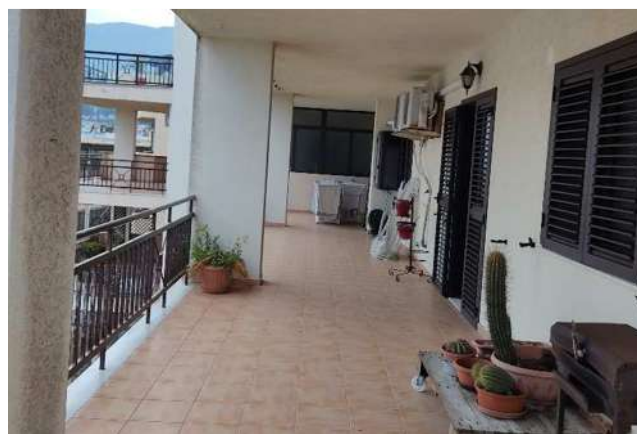
foto n.10 balcone su prospetto Sud
