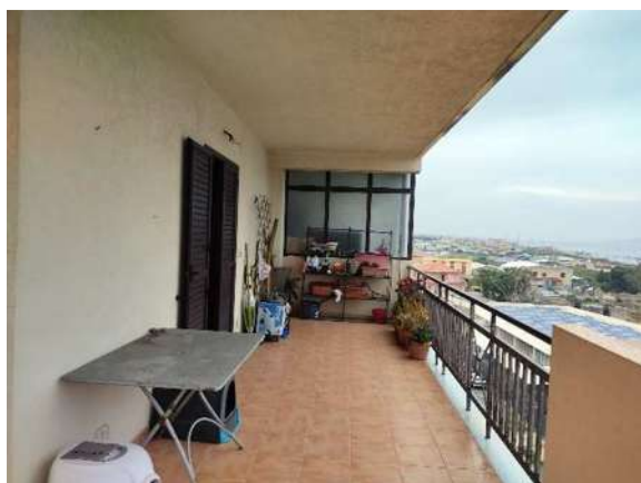
foto n.9 balcone su prospetto Est
