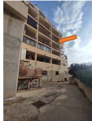
foto n.2 Prospetto Sud su corte
