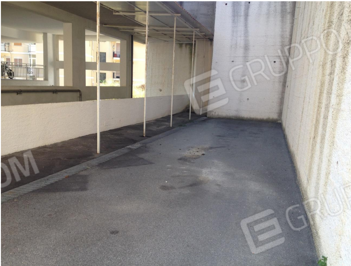
Porzione tra l'intercapedine ed il muro di sostegno del terrapieno
