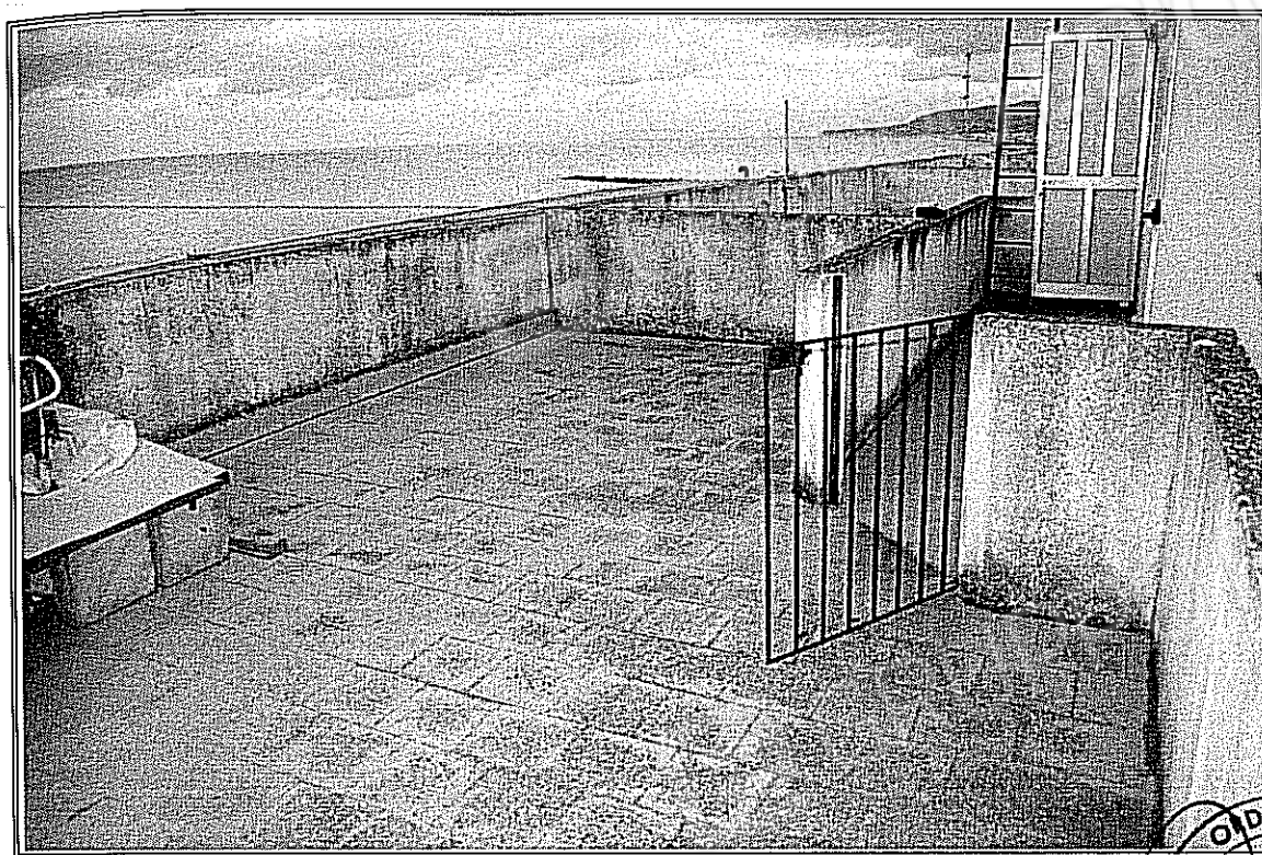
FOTO 13 – F. 2 part. 1358 – 1476 sub 31-Lastrico solare piano quarto
