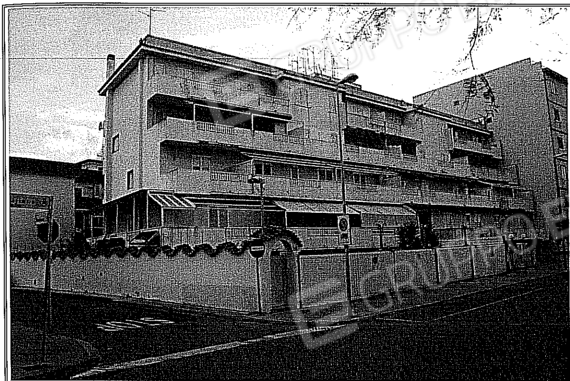
FOTO 1 – Prospetto su Via Lungomare
