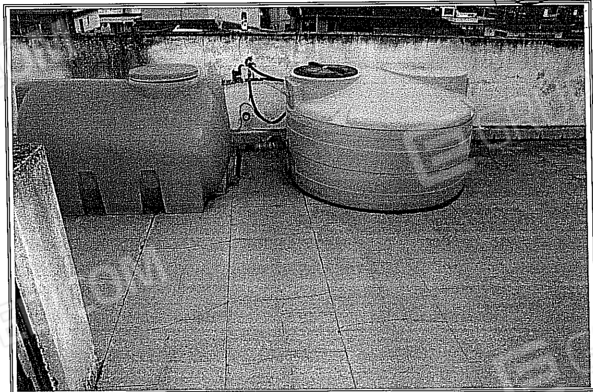
FOTO 20 – F. 2 part. 1358 – 1476 sub 29 – Lastrico solare piano quarto
