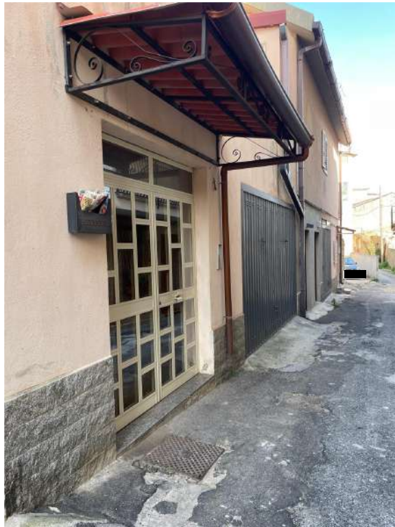
foto n. 3 portone d'ingresso al fabbricato
