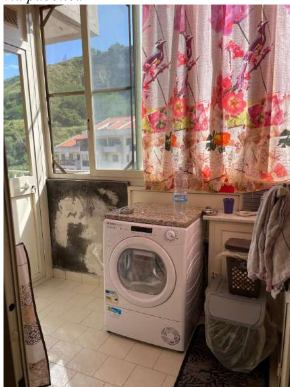
foto n. 30 struttura precaria in alluminio e vetro realizzata sul balcone prospiciente la via pubblica
