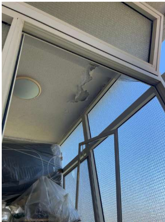
foto n. 24 balcone su spazio interno
