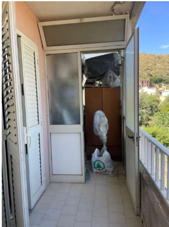
foto n. 23 balcone su spazio interno
