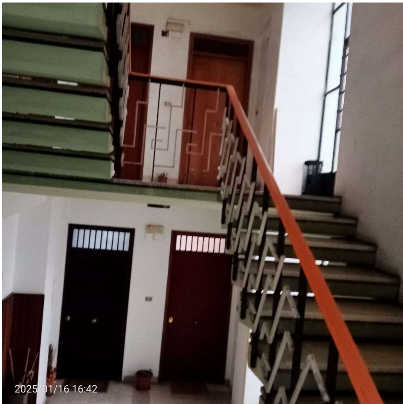
Foto 3 – Vista del vano scala condominiale
