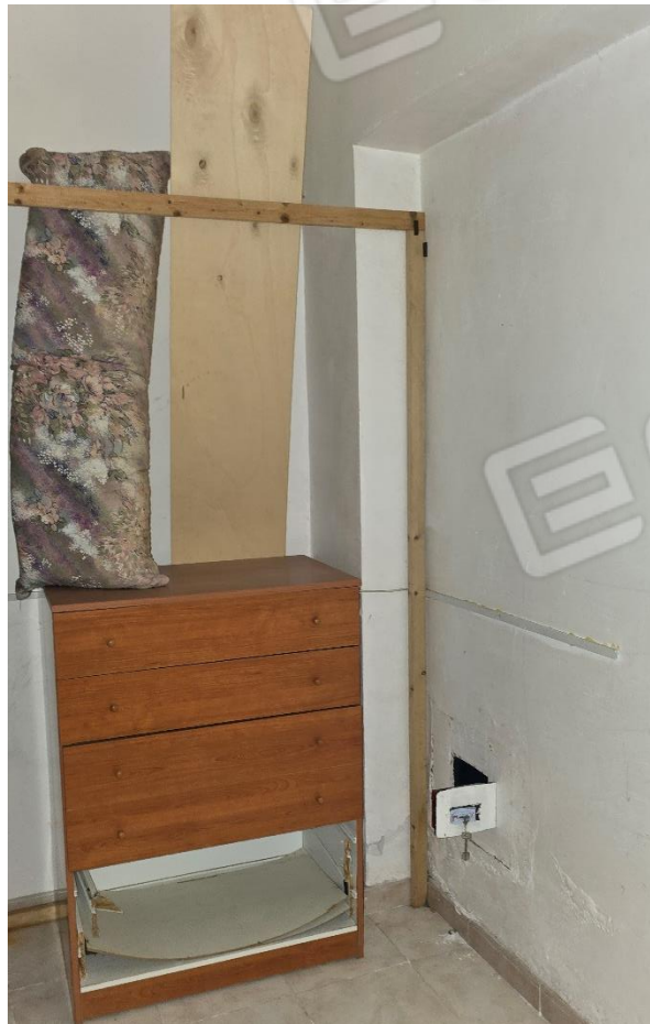
Foto 2 - RIPOSTIGLIO A SERVIZIO DELLA STANZA
