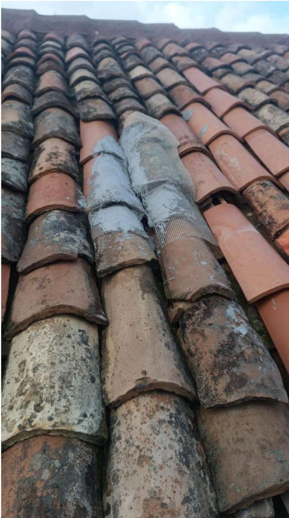
foto 4 – stato del manto di tegole
