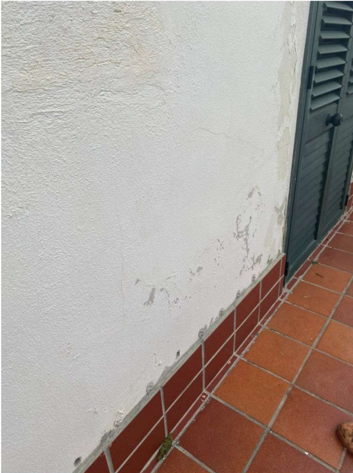
foto 10 – esterno parte lato est umidità di risalita
