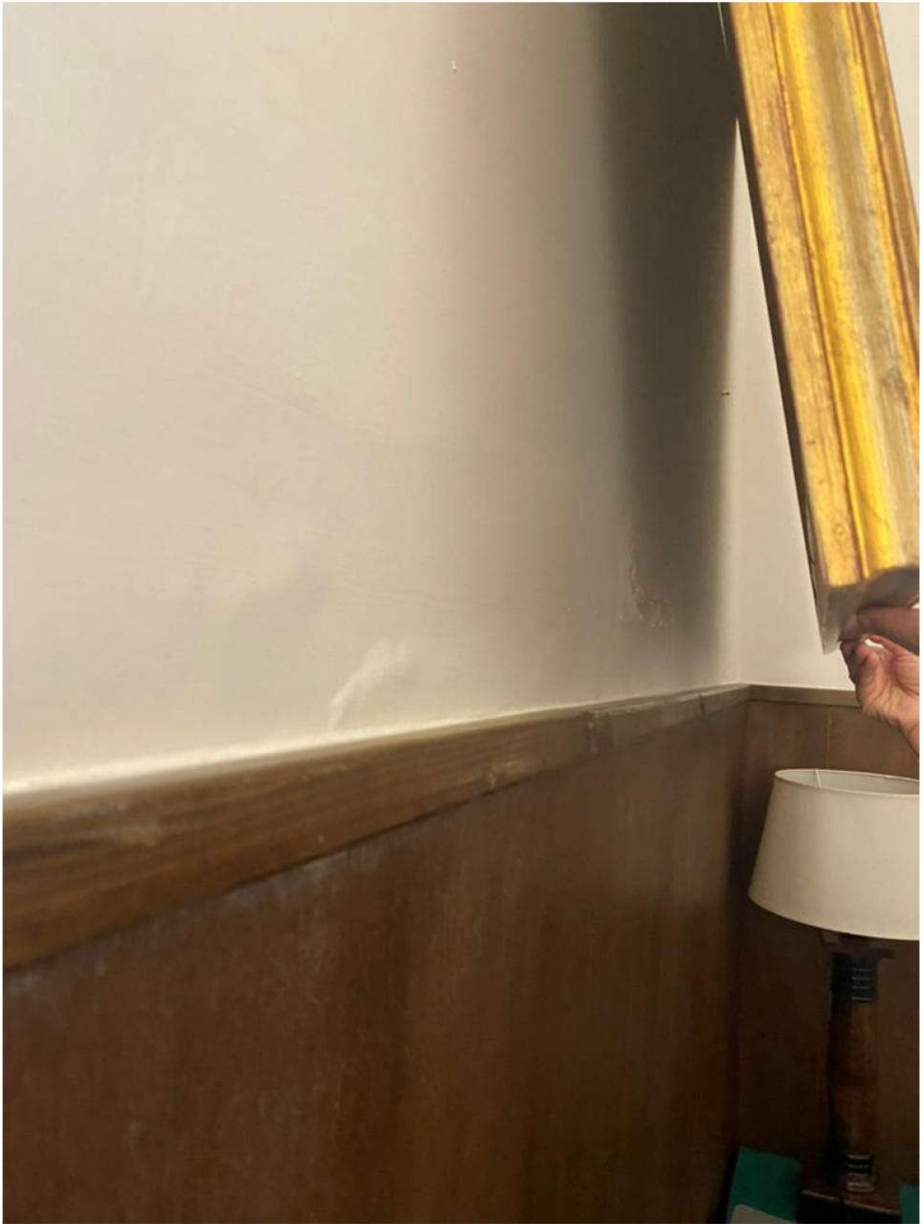
foto 8 – umidità di risalita parete lato est, oltre il rivestimento in legno
