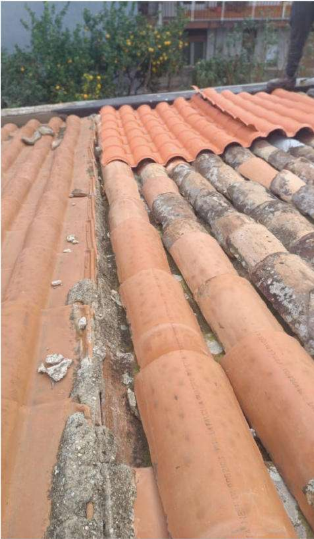
foto 1 – “Riparazione” locale con pannelli in pvc
