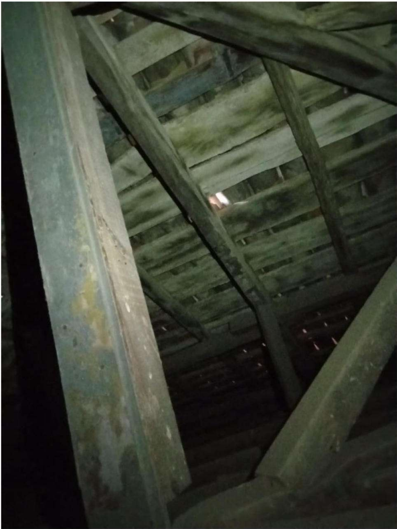
foto 5 – vista del tetto dall'interno si noti la discontinuità del manto di tegole e lo stato di degrado ed inconsistenza del tavolato
