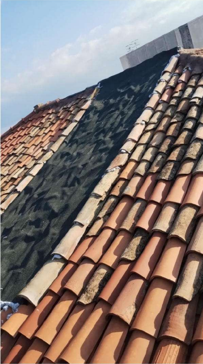
foto 3 - “Riparazione” locale con sovrapposizione di guaina bituminosa
