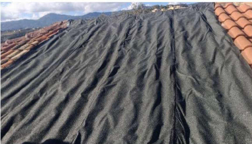
foto 2- "Riparazione" locale con sovrapposizione di guaina bituminosa
