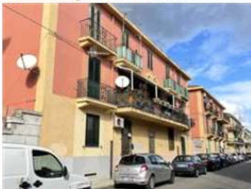
Fronte del fabbricato su Via Reggio Calabria
