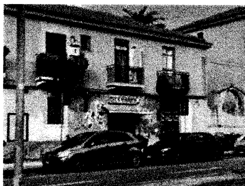
Fronte del fabbricato su Via La Farina
