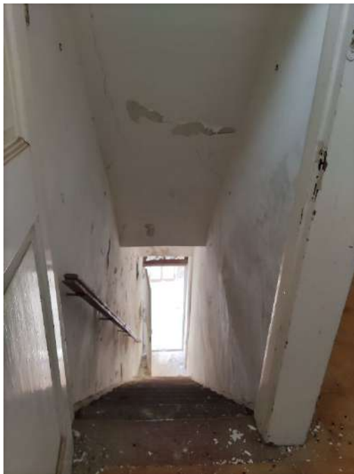
10. Scala di accesso al sub 5
