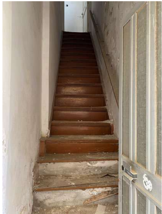
9. Scala di accesso al sub 5
