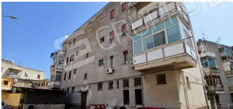
FOTO 3- Ingresso al fabbricato (Pal. G) dalla Via Saverio Parisi .
