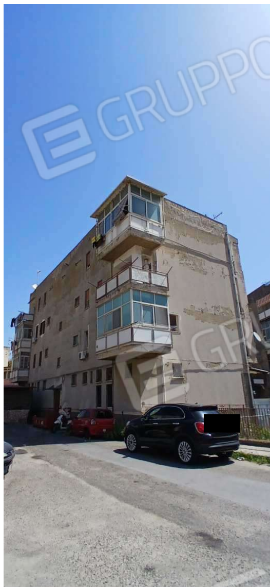
FOTO 1 - Veduta del fabbricato di ricadenza, prospetto principale su Via S. Parisi .
