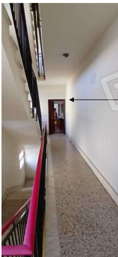
FOTO 6 - Sbarco scala su pianerottolo condominiale del P.1°. Sul fondo porta ingresso unità immobiliare .
