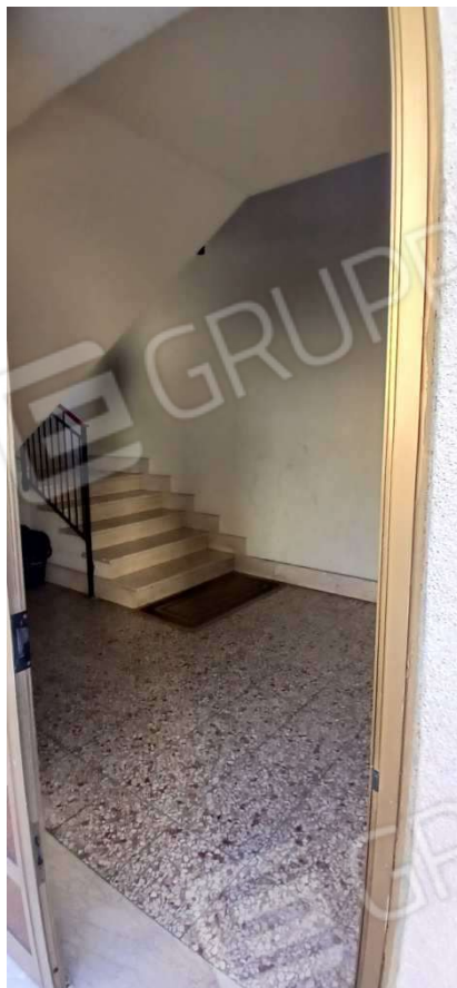
FOTO 5 - Androne e rampa scale condominiale (privi di ascensore).
