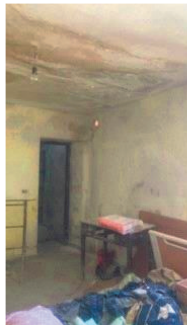
tramezzo con realizzazione bagno 1 piano
