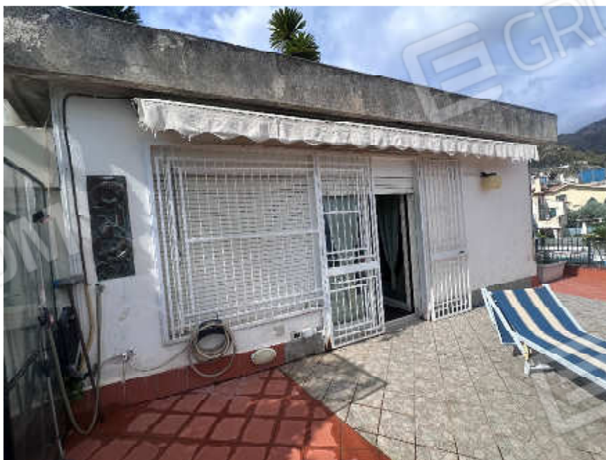
Foto nr.8 : prospetto dell'immobile lato mare
