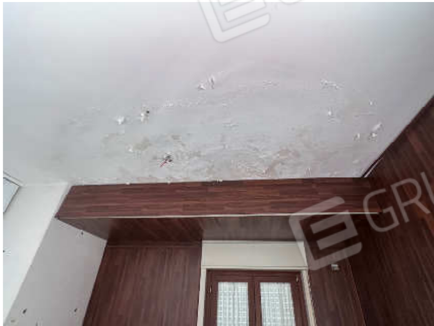
Foto nr.10: particolare dell'infiltrazione di umidità proveniente dal terrazzo soprastante
