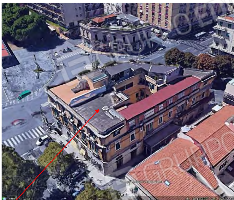
Lastrico Solare sub 40 Cat. F/5 - piano 3°
