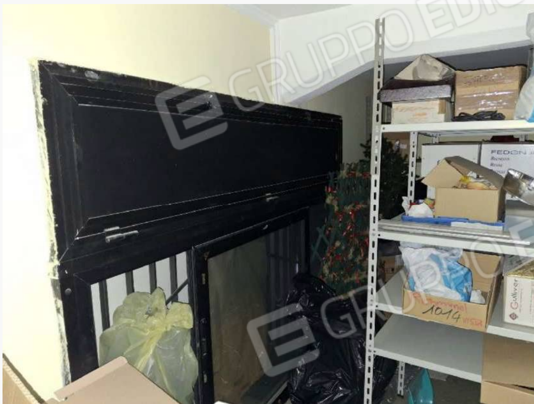
Infisso sovrastante la porta d'ingresso al locale
