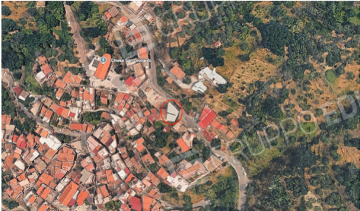
1. Fabbricato visto da Google Maps
