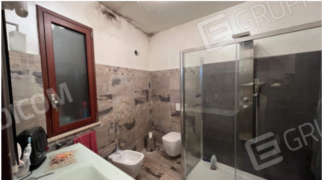
16. Vista 1 su Bagno al Piano Primo
