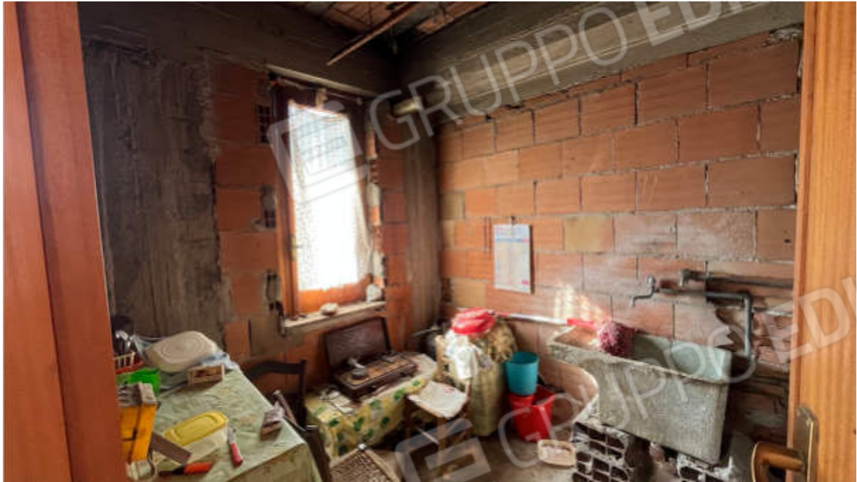
13. Vista su Lavanderia al Piano terra
