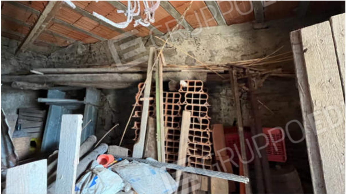
31. Vista 2 su Deposito 1
