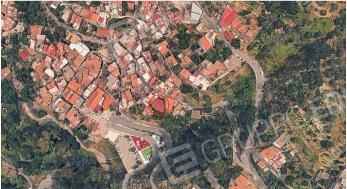
1. Fabbricato visto da Google Maps
