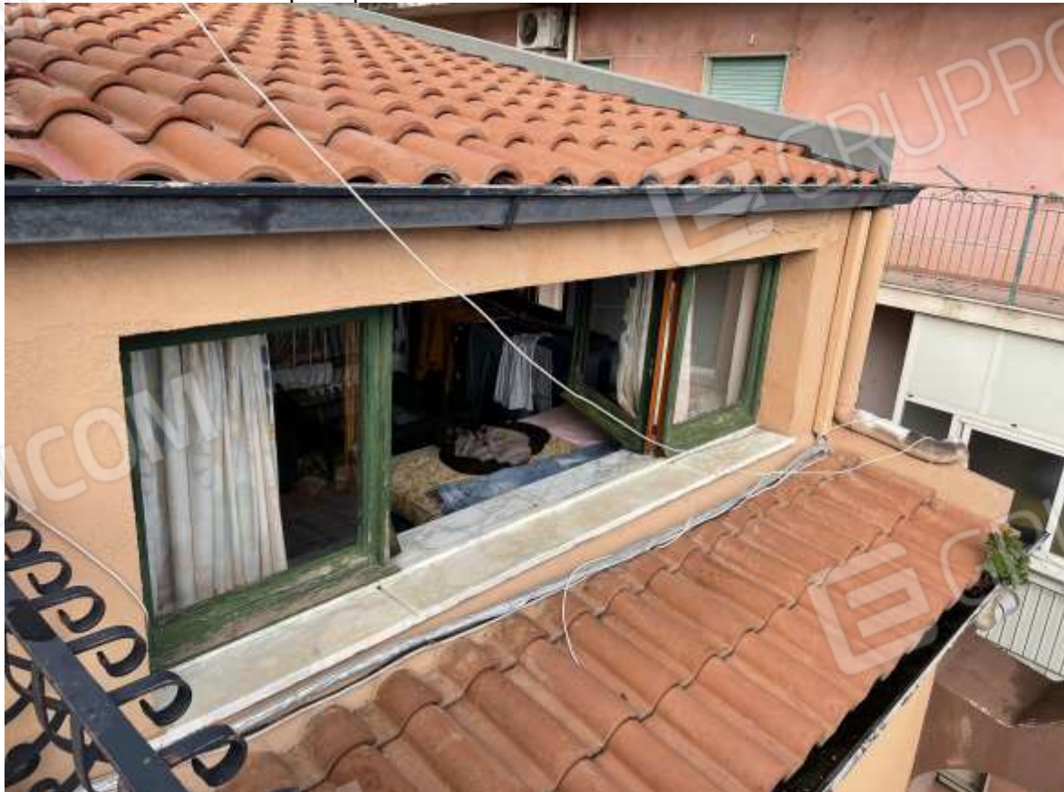
FOTO N. 12 – Vista vano principale
