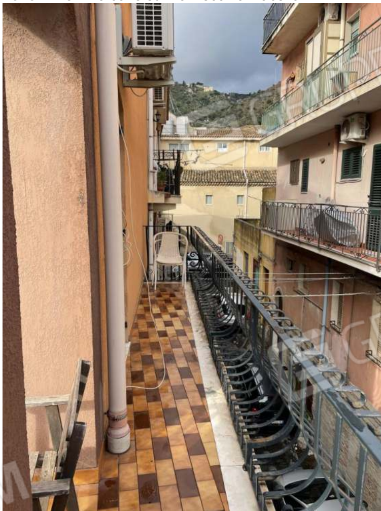
FOTO N. 18 – Balcone su Via Vecchio Macello
