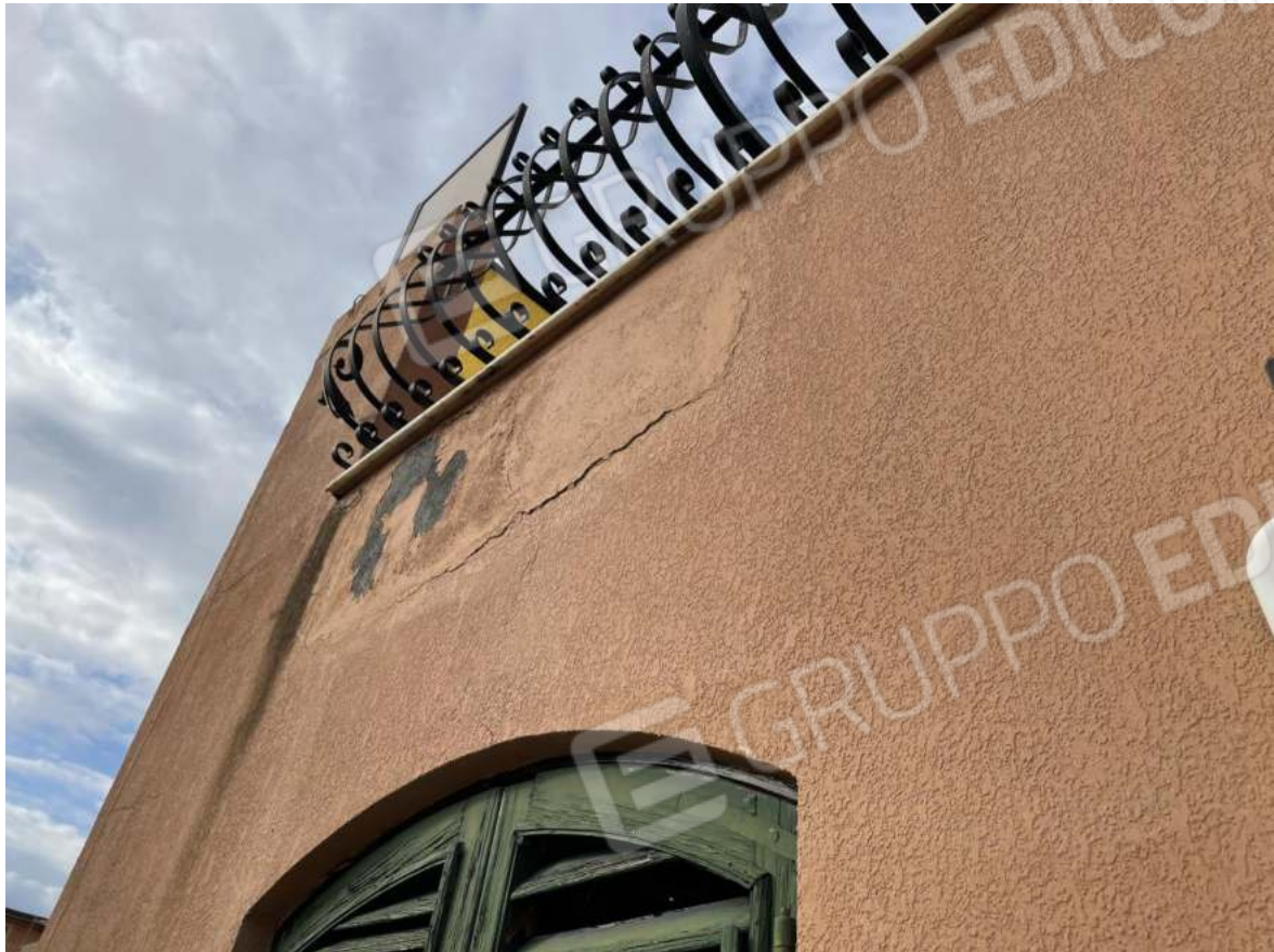
FOTO N. 14 – Parete esterna della camera
