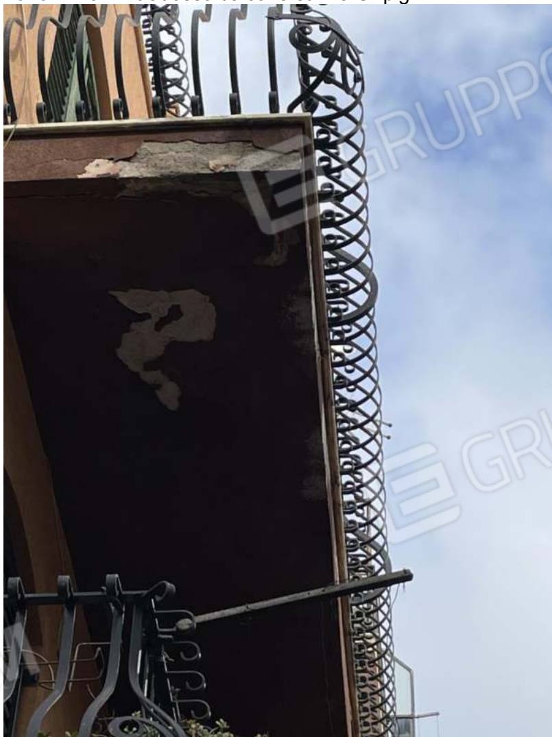
FOTO N. 16 – Intradosso balcone su Via Silipigni
