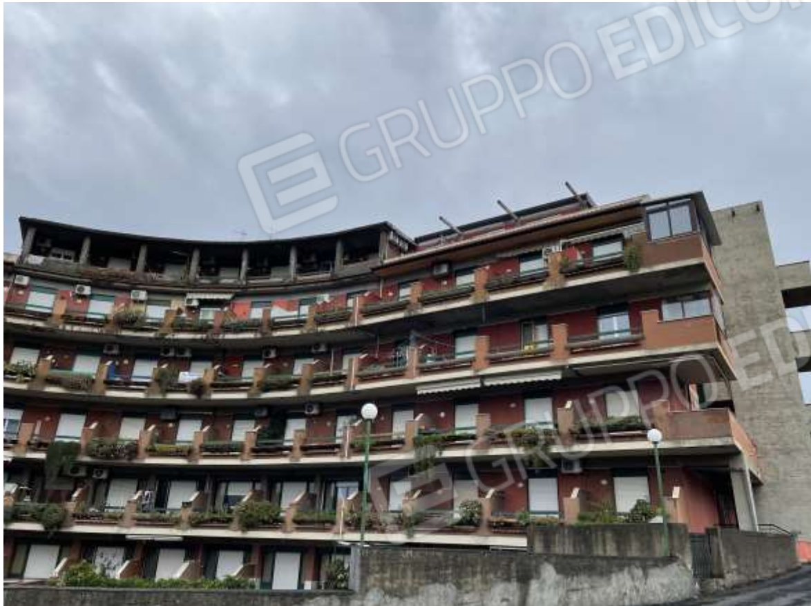
FOTO N. 3 – Vista del fabbricato ala Etna
