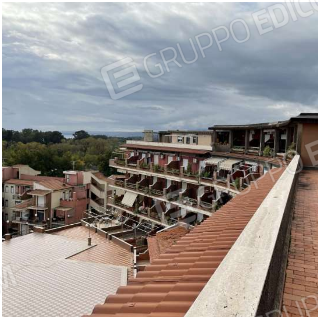
FOTO N. 11 – Vista dalla terrazza
