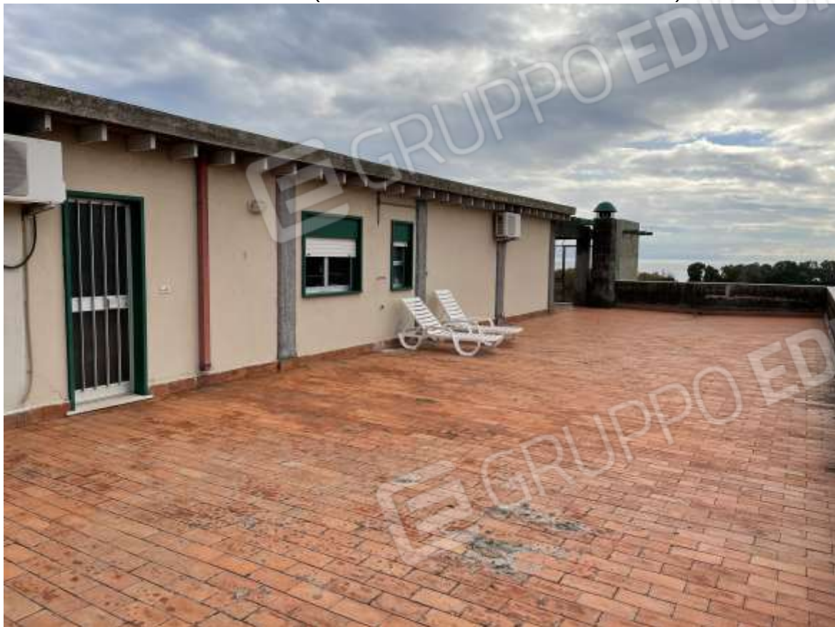
FOTO N. 5 – Vista del monolocale (in successione monolocale LOTTO 11)
