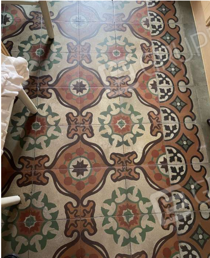
FOTO N. 17 – Particolare della pavimentazione della cucina
