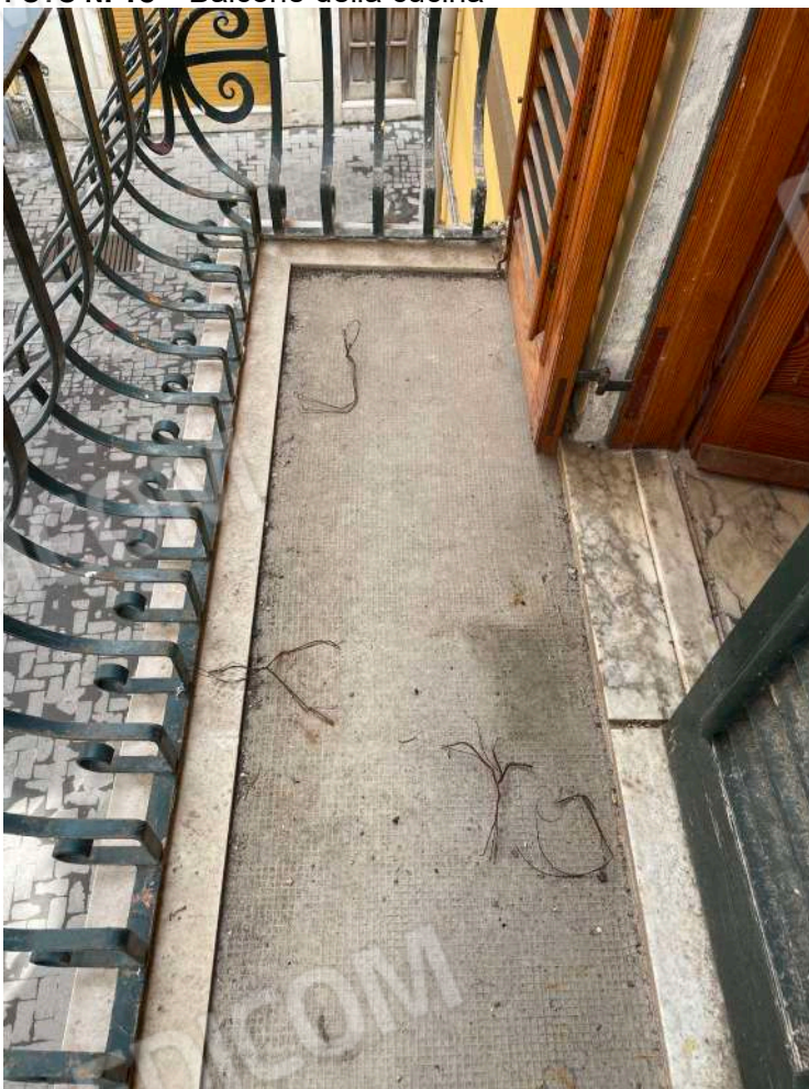
FOTO N. 18 – Balcone della cucina
