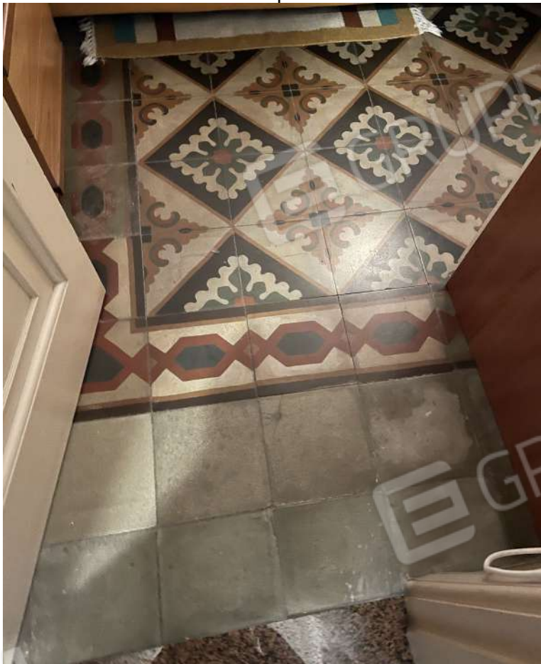
FOTO N. 11 – Particolare della pavimentazione della camera
