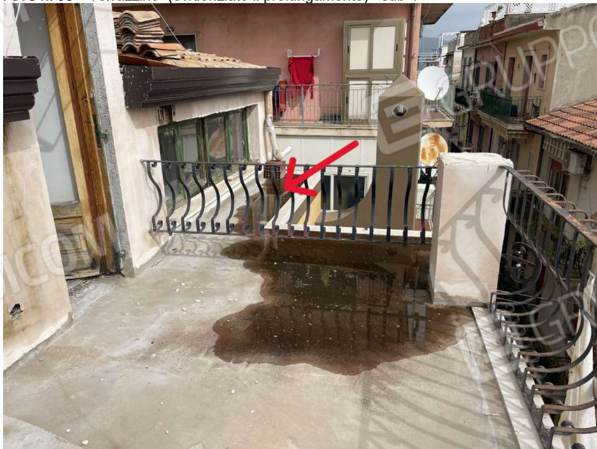
FOTO N. 38 – Terrazzino (evidenziato il prolungamento)– sub 4
