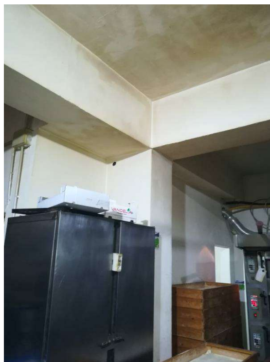
Foton.4 : Particolare della zona adibita a preparazione pane ;
