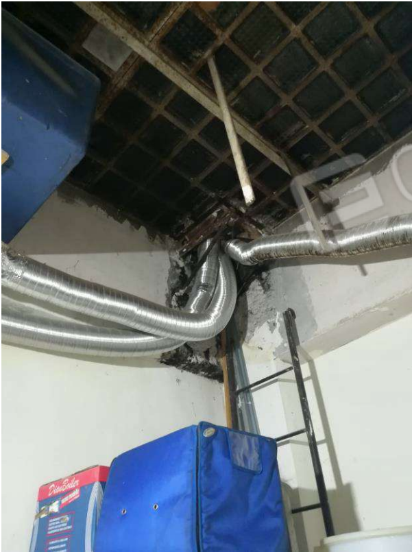
Foto n. 7 : dettaglio della copertura a vetri della chiostrina;
