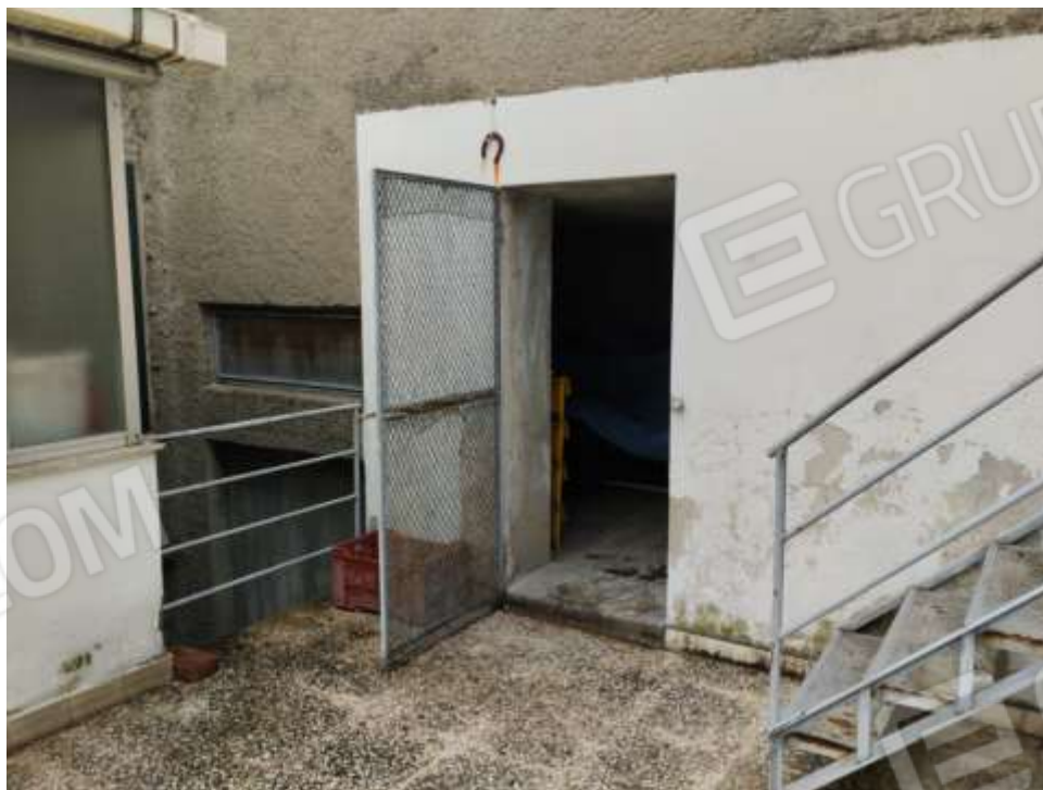
Foto n. 12 – accesso deposito piano primo part 242 sub. 10
