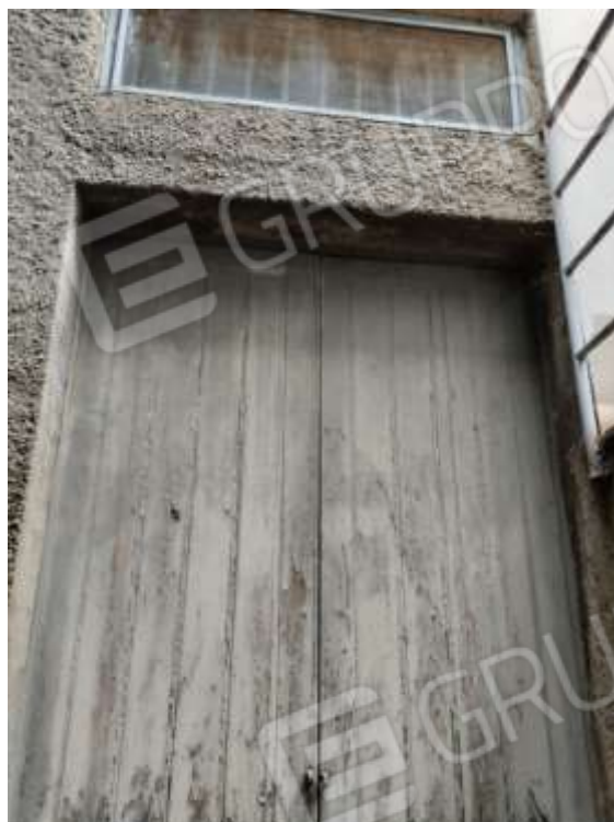
Foto n. 11 – Ingresso al deposito piano terra part. 242 sub. 9
