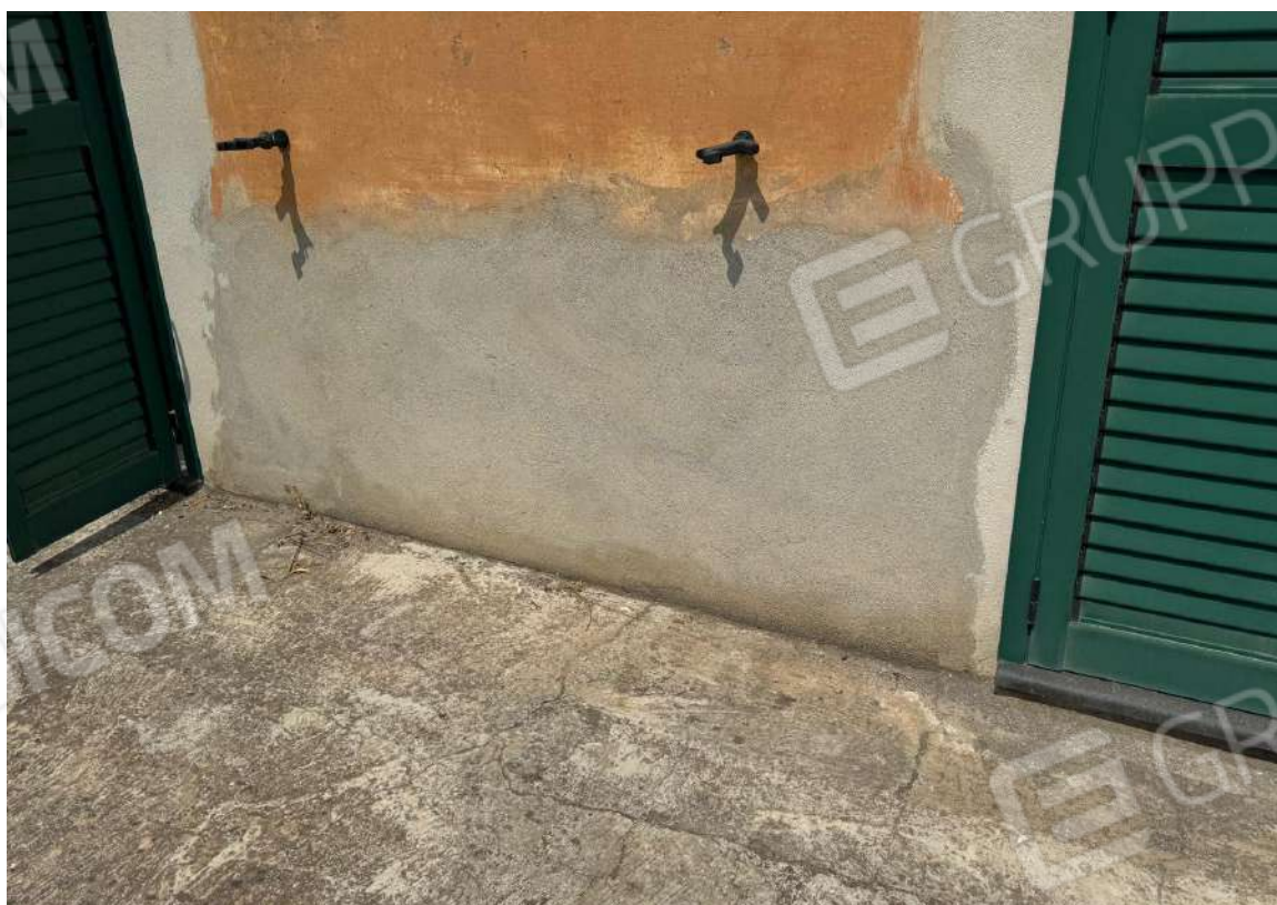
Foto 40 – Risanamento superfici prospettiche ammalorate e segni della sostituzione di infissi e schermature
