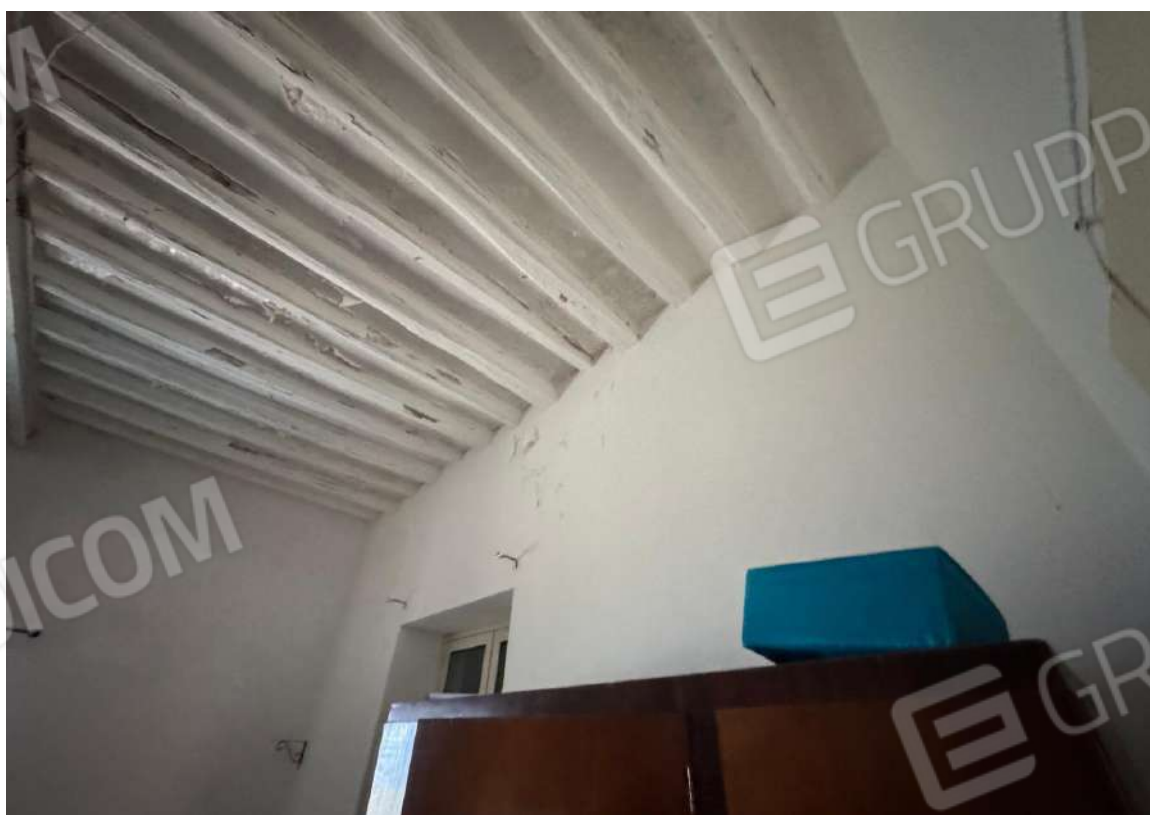
Foto 28 – Camera 3 – Particolare intradosso del solaio di copertura
