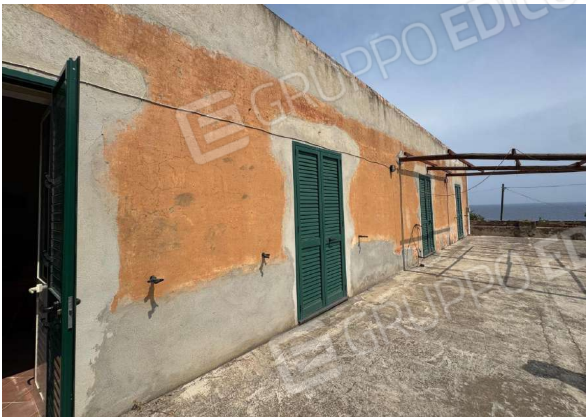
Foto 37 – Prospetto Est – particolare infisso e schermature esterne (persiane)
