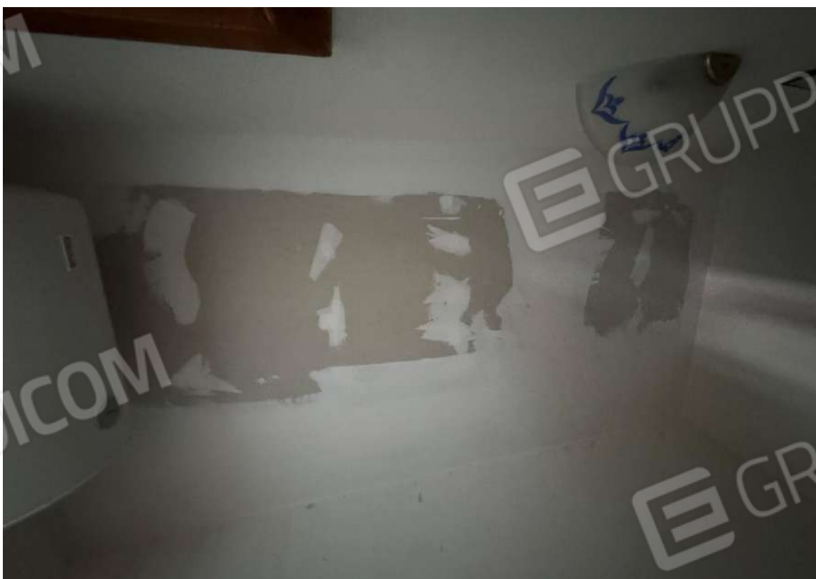
Foto 34 Bagno – Particolare del Controsoffitto
