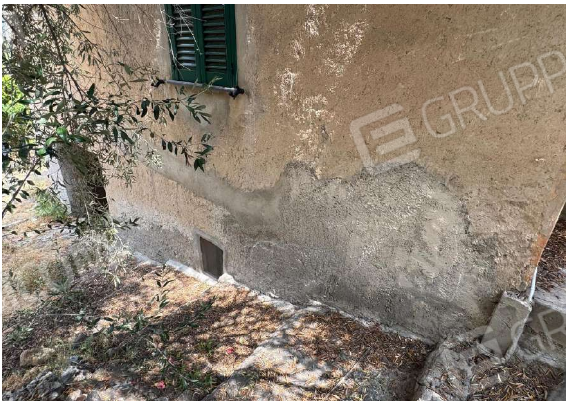
Foto 42 – Interventi di risanamento localizzati sul Prospetto Sud
