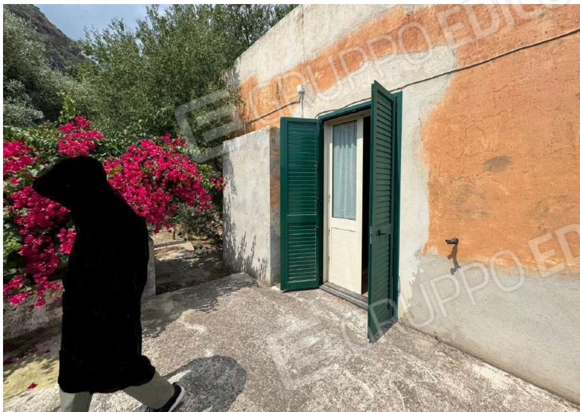
Foto 39 – Particolare interventi manutentivi e di risanamento delle superfici del prospetto Est
