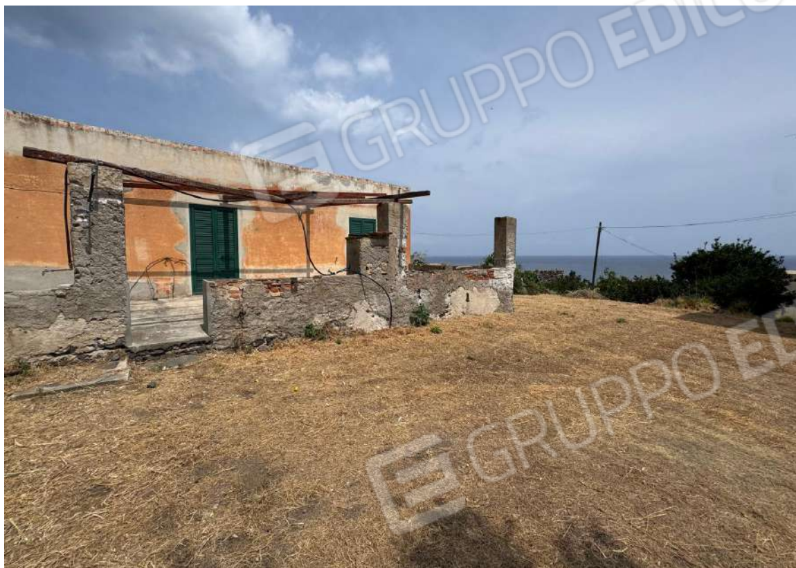
Foto 35 – Prospetto Est del fabbricato
