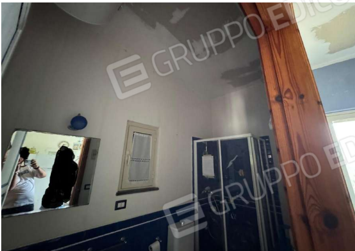
Foto 33 – Bagno – Particolare rivestimenti, infisso e impianto elettrico sottotraccia
