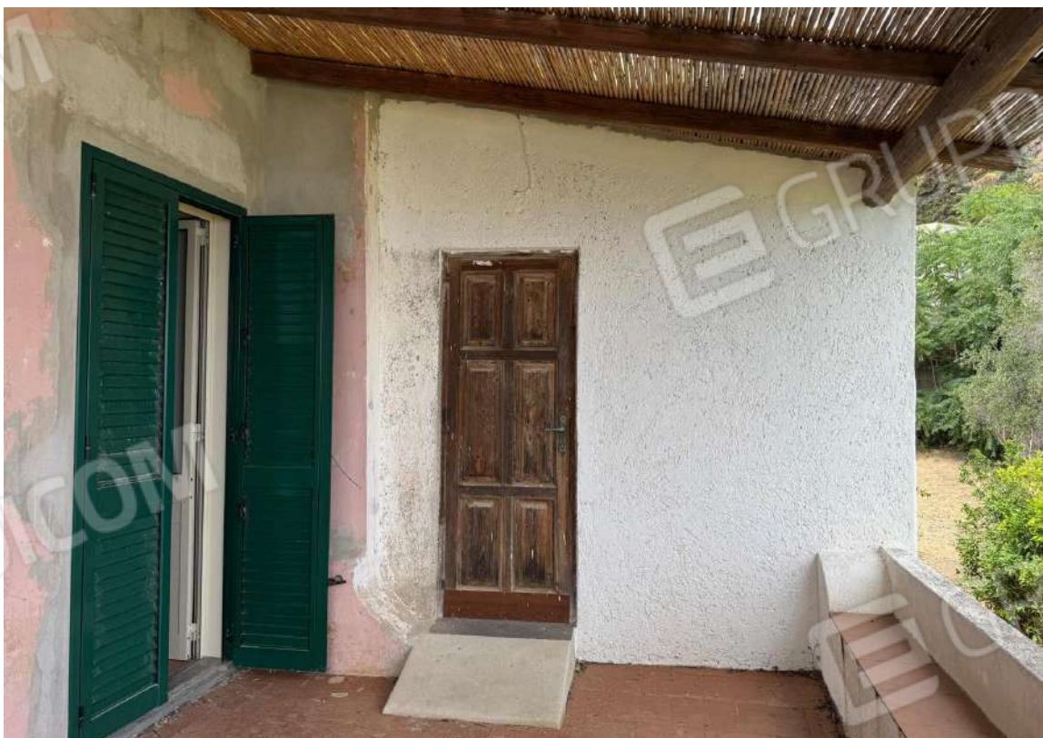
Foto 38 – Portico – Particolare porta-finestra e schermatura esterna (persiana)
