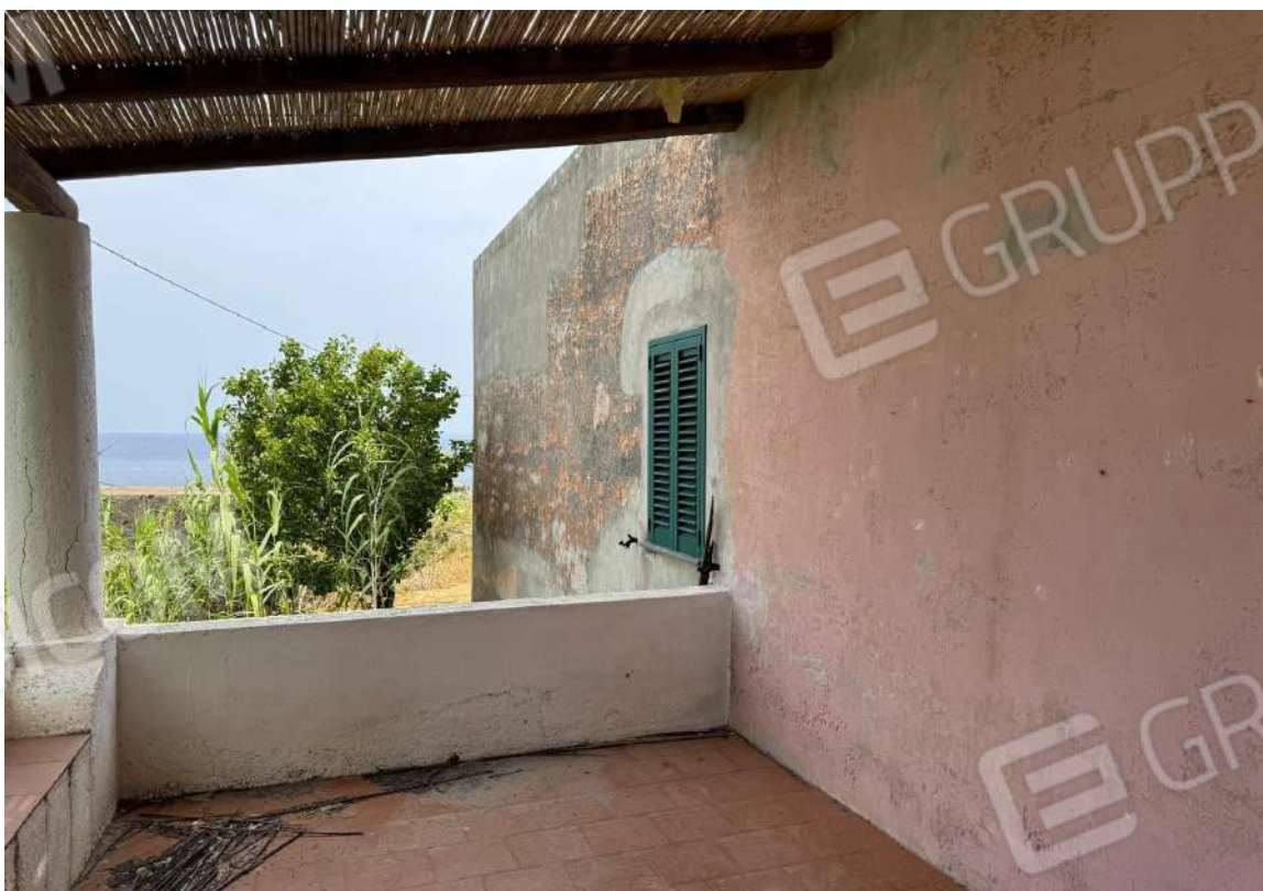
Foto 44 – Portico esterno su prospetto Ovest con copertura cannucciato – Particolare cavallature prospettiche
