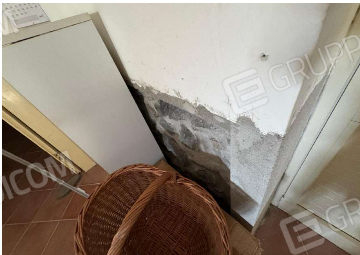
Foto 20 – Camera 1 – Particolare rifacimento superficie verticale interna pareti perimetrali
