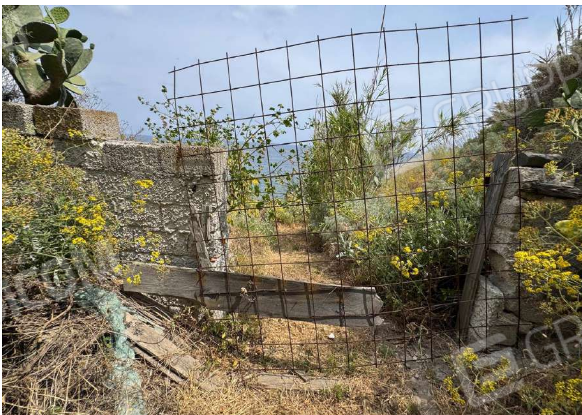
Foto 60 – Chiusura del varco si accesso alla spiaggia da terreno con rete metallica elettrosaldata
