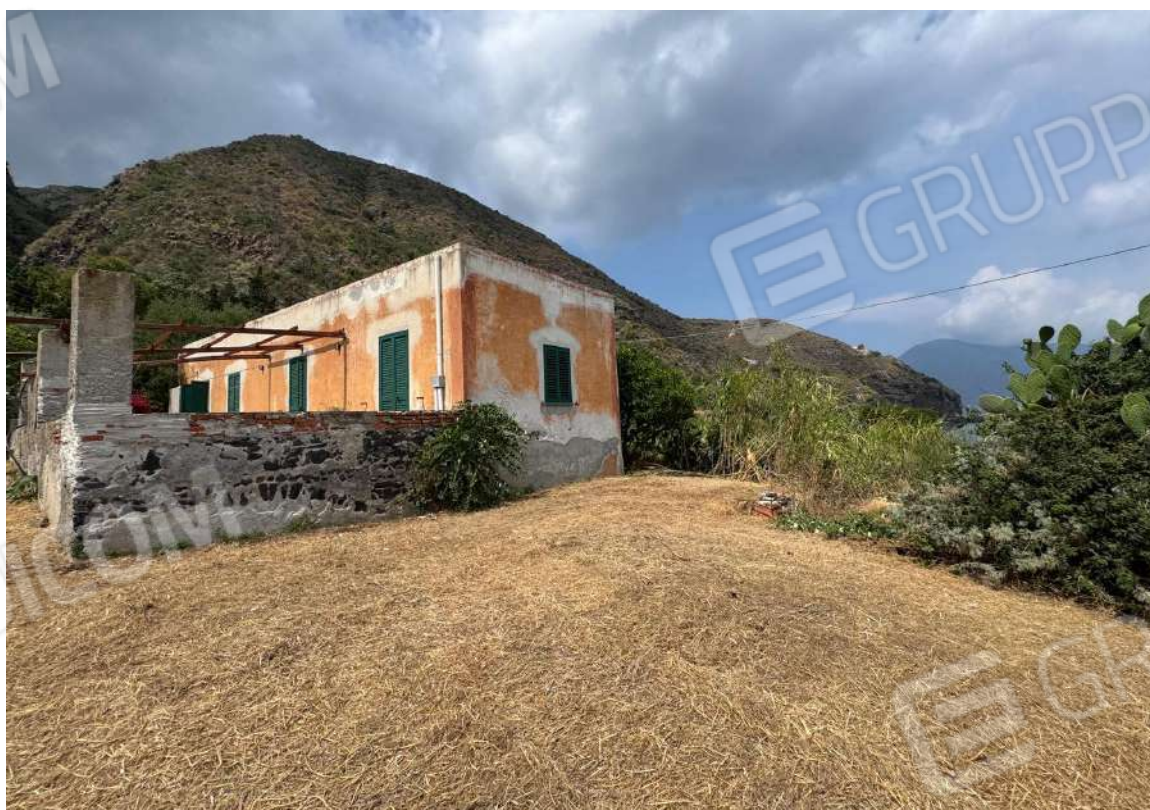
Foto 36 – Prospetto Nord del fabbricato
