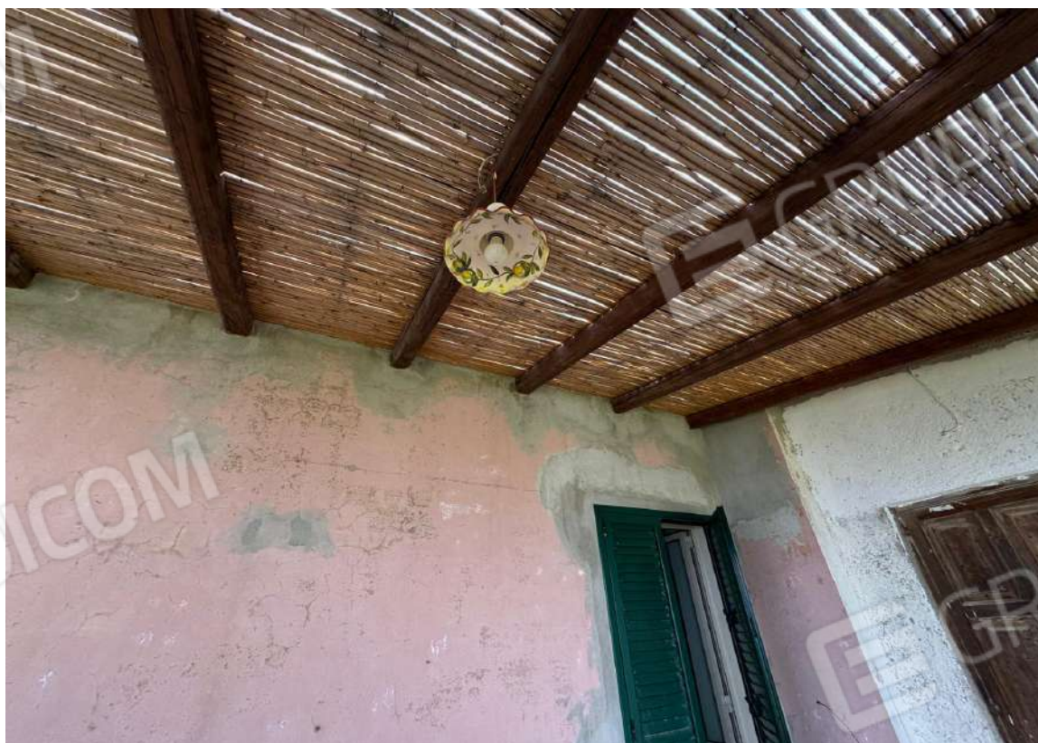
Foto 46 – Portico su prospetto Ovest e copertura in traversi in legno e cannucciato
