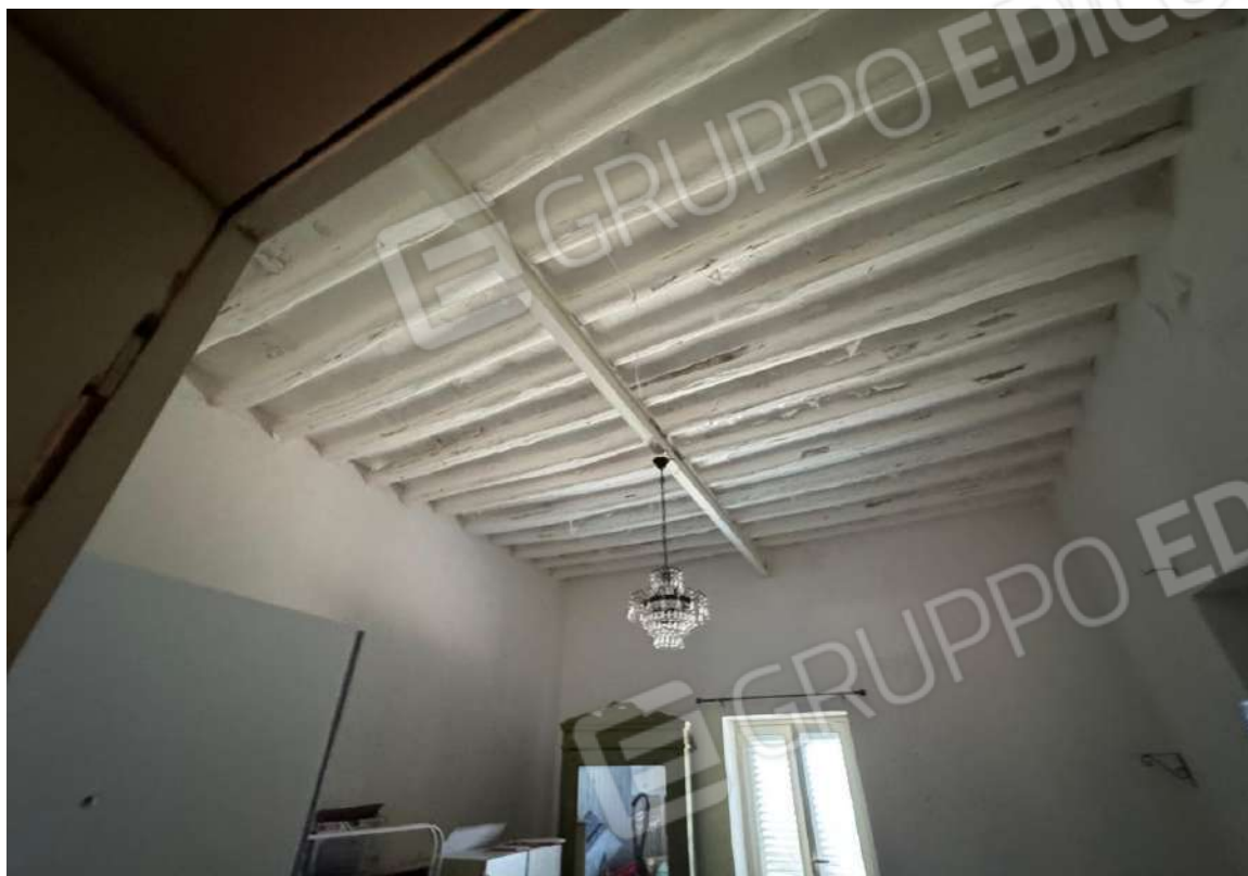
Foto 27 – Camera 3 – Particolare intradosso del solaio di copertura
