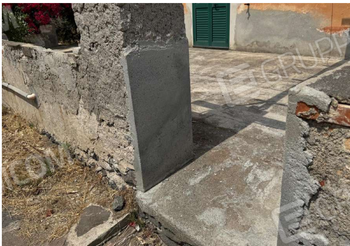
Foto 50 – Patio su prospetto Est – riparazioni del varco d’accesso da terreno limitrofo il fabbricato
