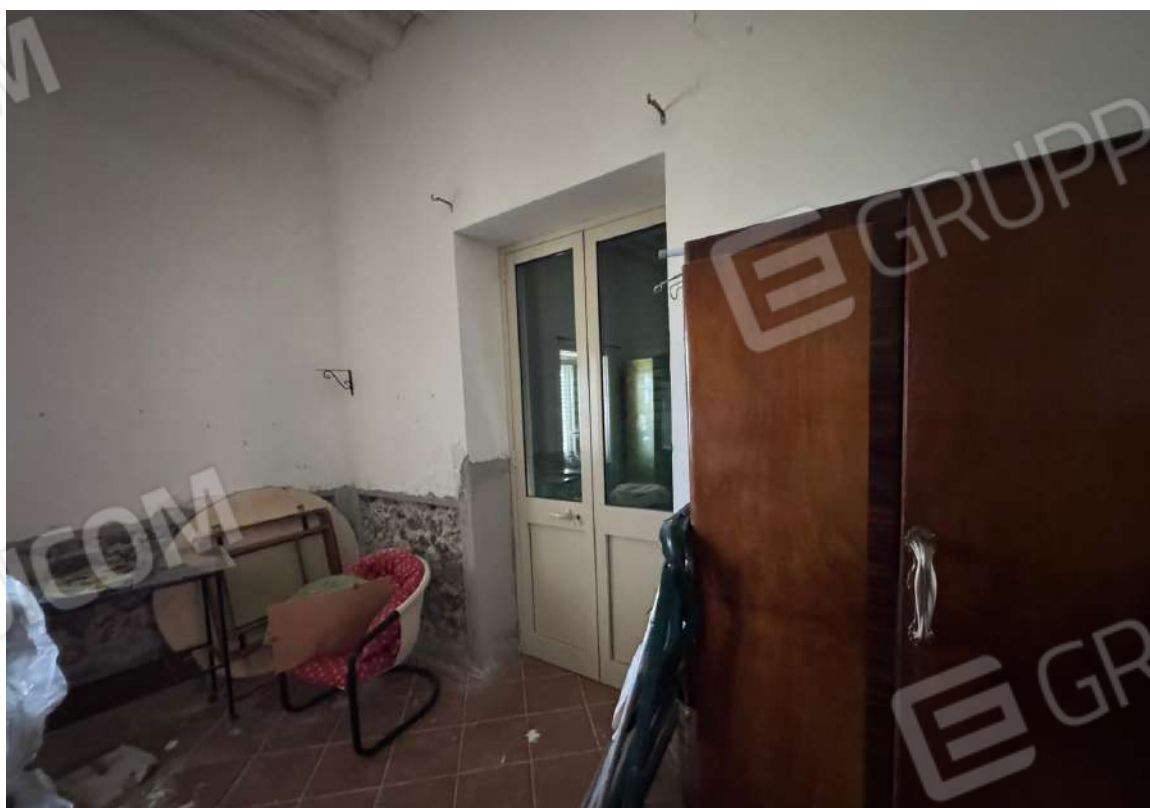
Foto 30 – Camera 3 – Particolare rifacimento superficie verticale interna in pietra delle pareti perimetrali
