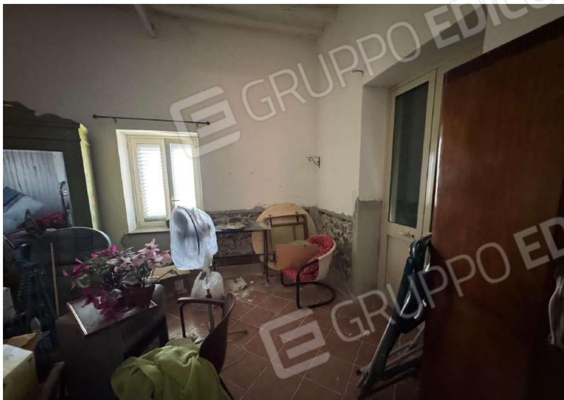
Foto 29 – Camera 3 – Particolare rifacimento superficie verticale interna in pietra delle pareti perimetrali
