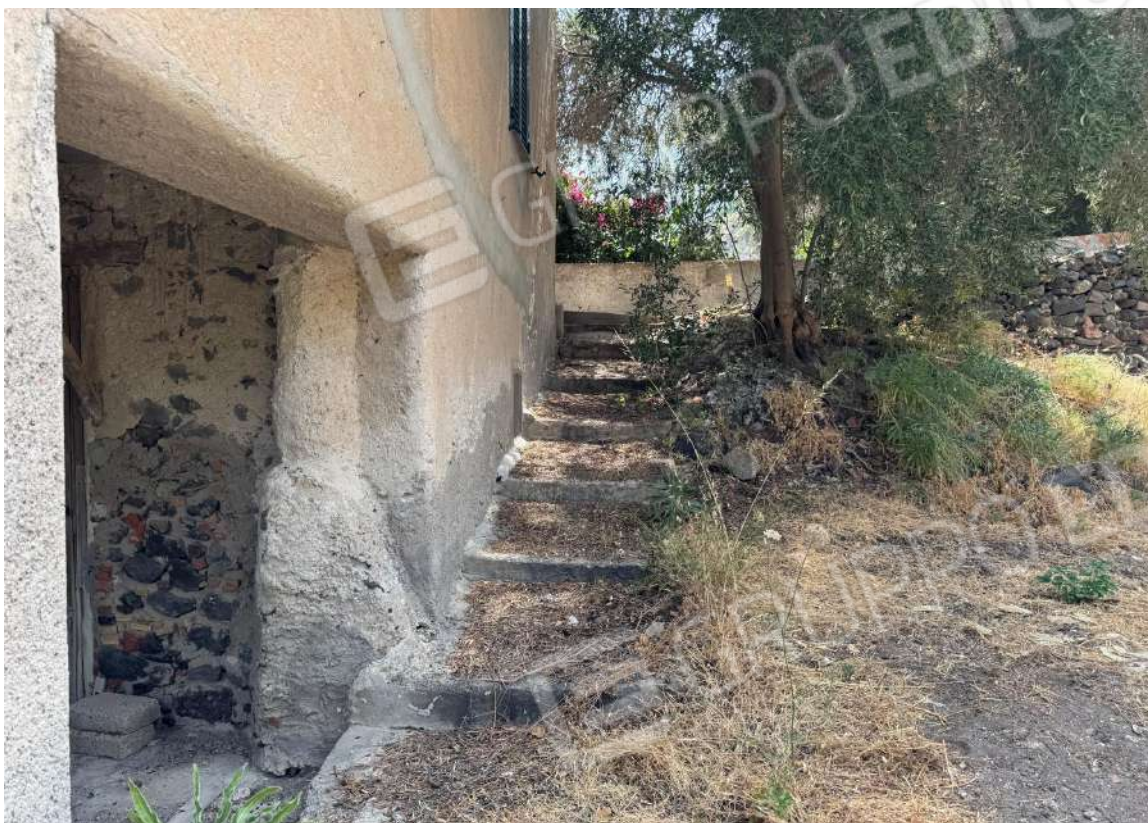
Foto 43 – Interventi di risanamento su prospetto Sud e in prossimità dell'accesso ai locali deposito
