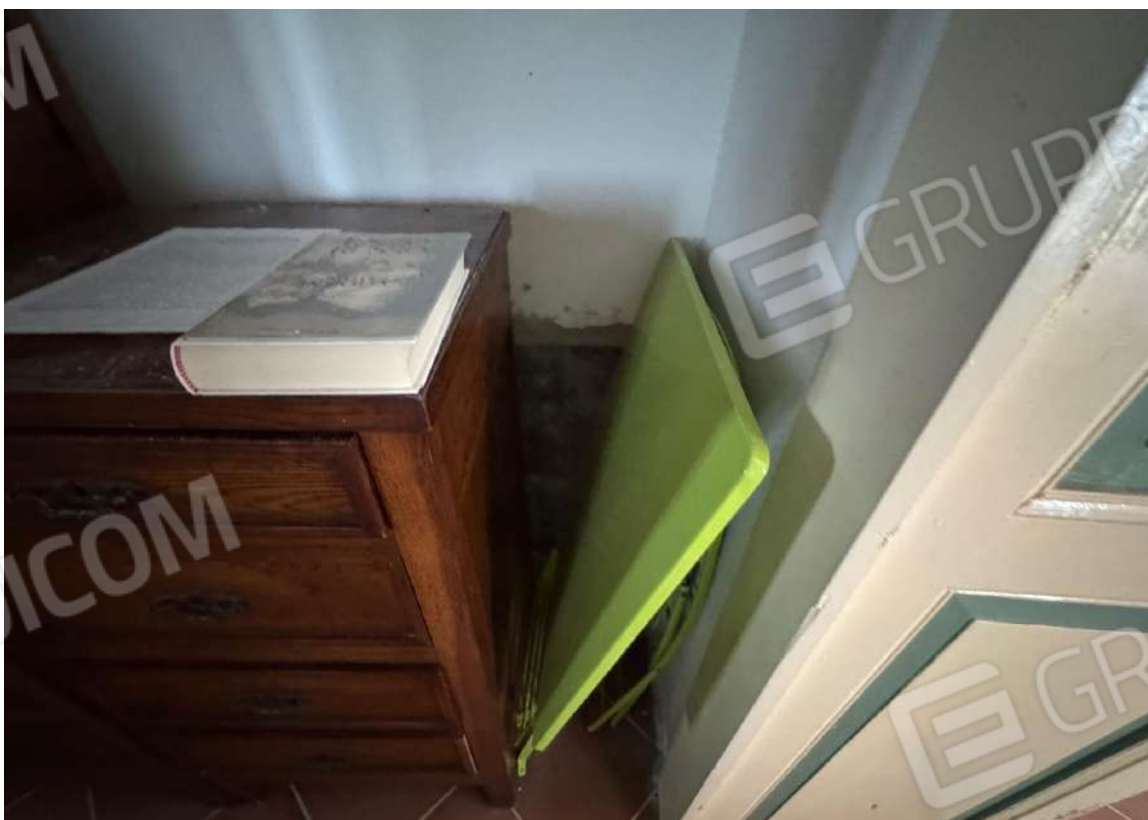
Foto 26 - Particolare porte interne e rifacimento superficie verticale interna in pietra delle pareti perimetrali
