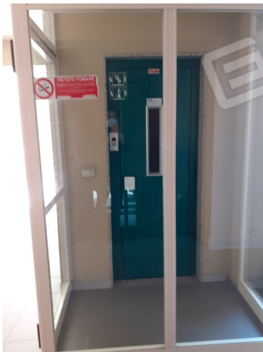
Foto nr. 2 : particolare del corpo ascensore
