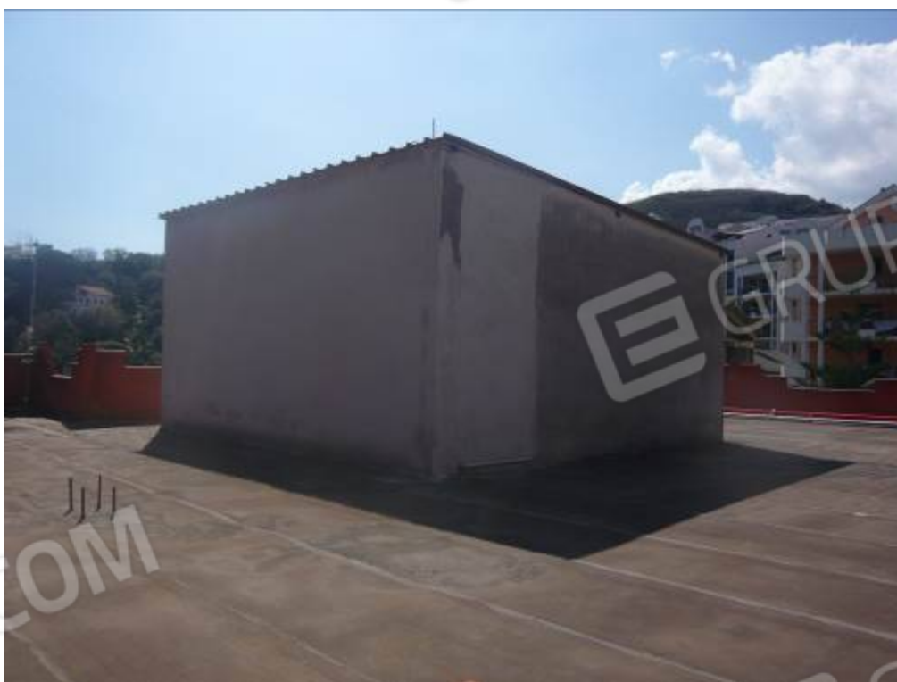
FOTO 49 – LASTRICO SOLARE CON LOCALE DEPOSITO
