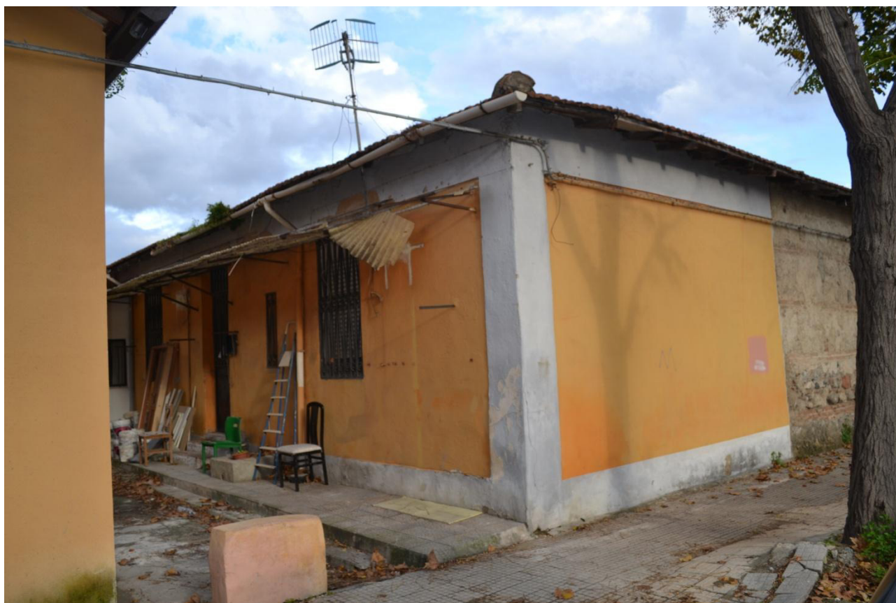
Fotografia n. 1 – Immobile dei debitori visto da Via San Cosimo
