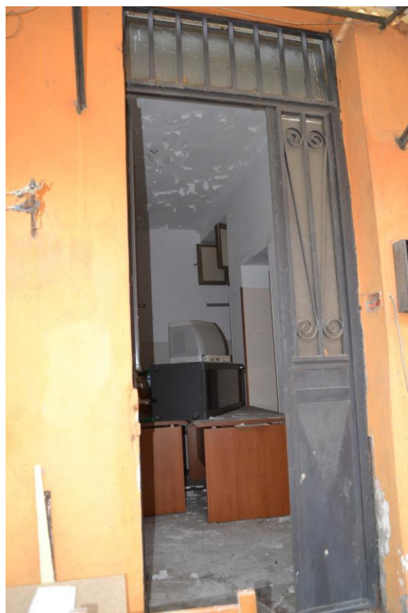
Fotografia n. 2 – Portone di ingresso immobile
