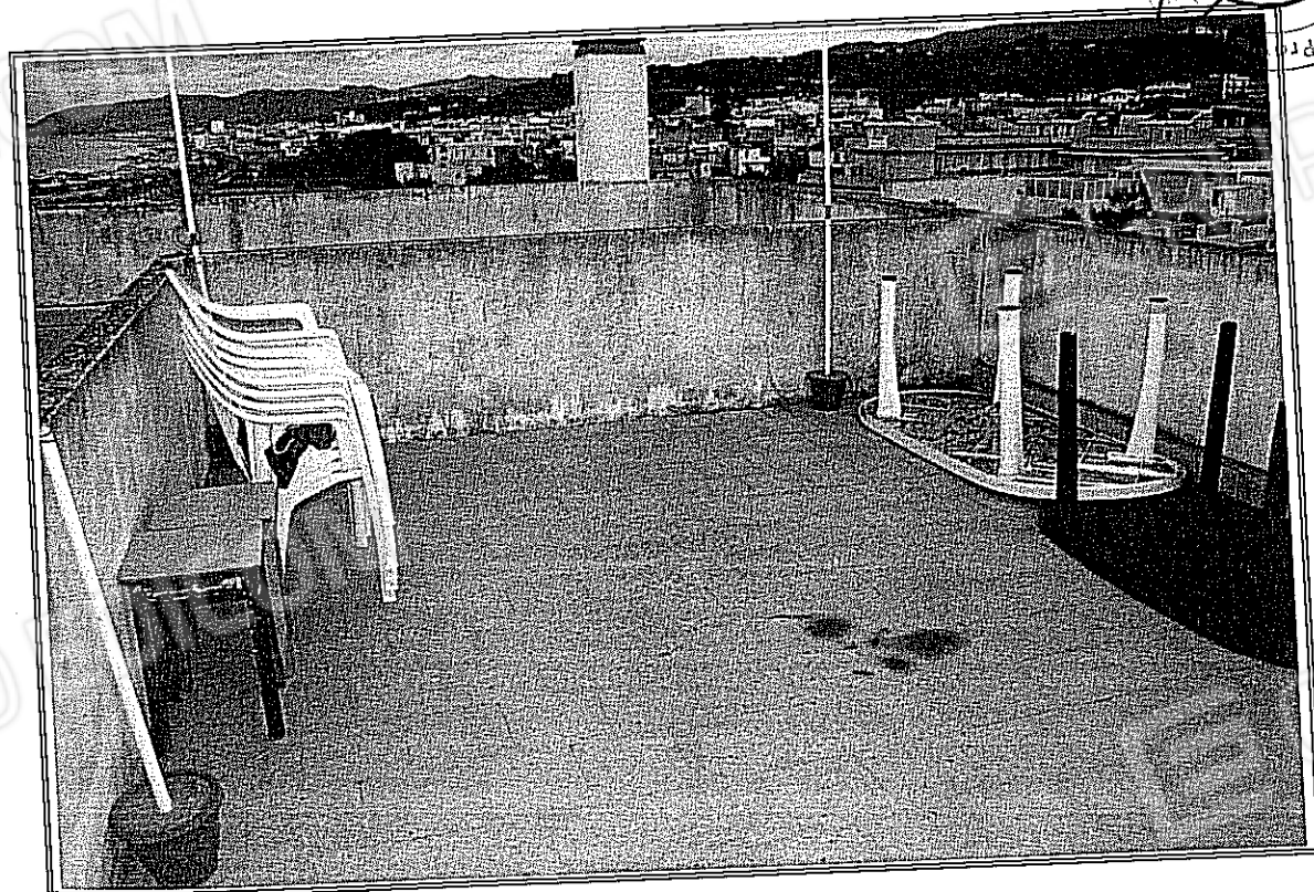
FOTO 26 – F. 2 part. 1358 – 1476 sub 28 – Lastrico solare piano quarto
