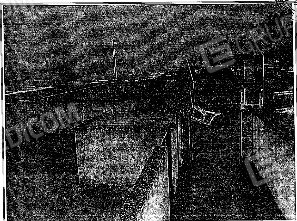
FOTO 30 - F. 2 part. 1358 - 1476 sub 27 - Lastrico solare piano quarto
