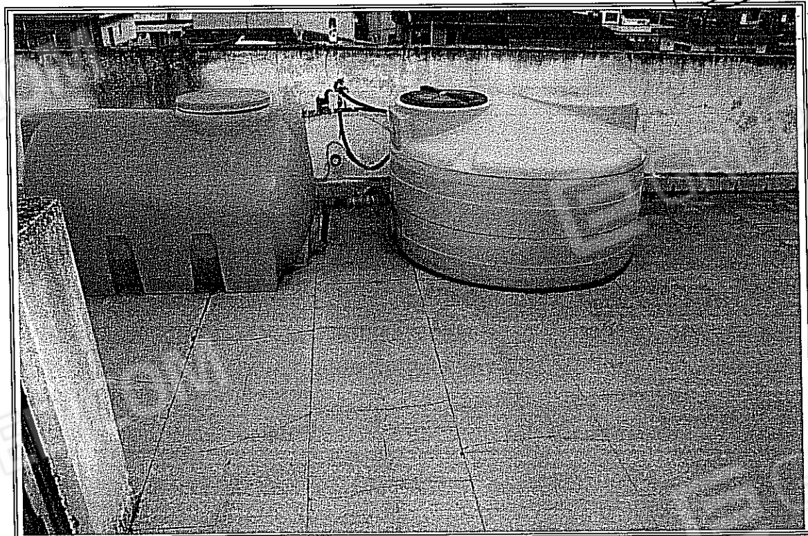
FOTO 20 – F. 2 part. 1358 – 1476 sub 29 – Lastrico solare piano quarto
