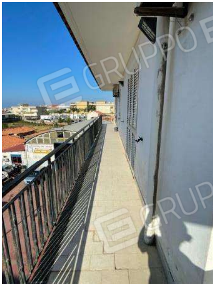
FOTO 29 – PIANO SECONDO BALCONE
