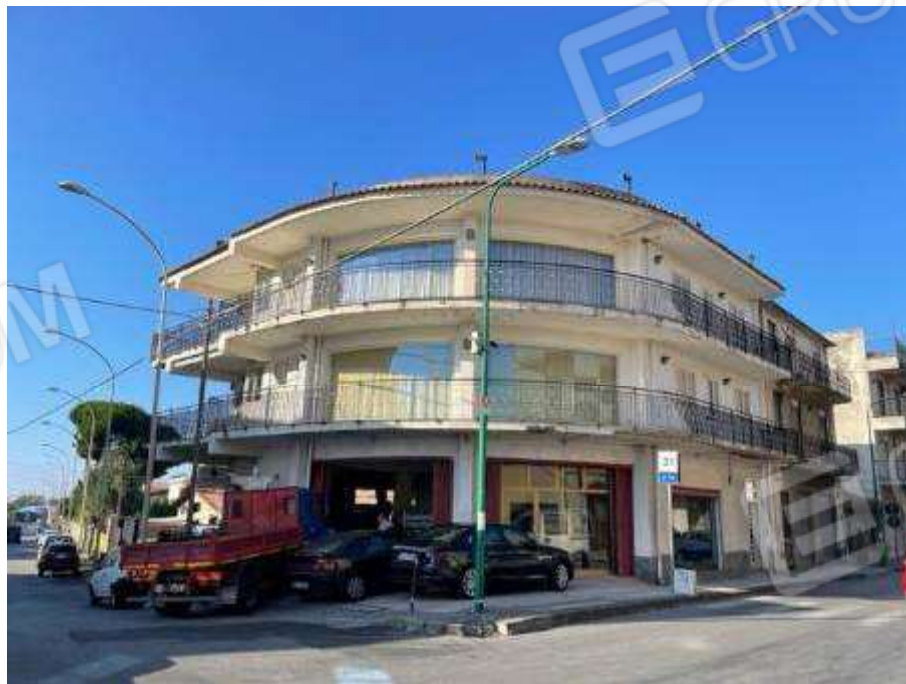
FOTO 2 – PROSPETTO SU VIA NAZIONALE
