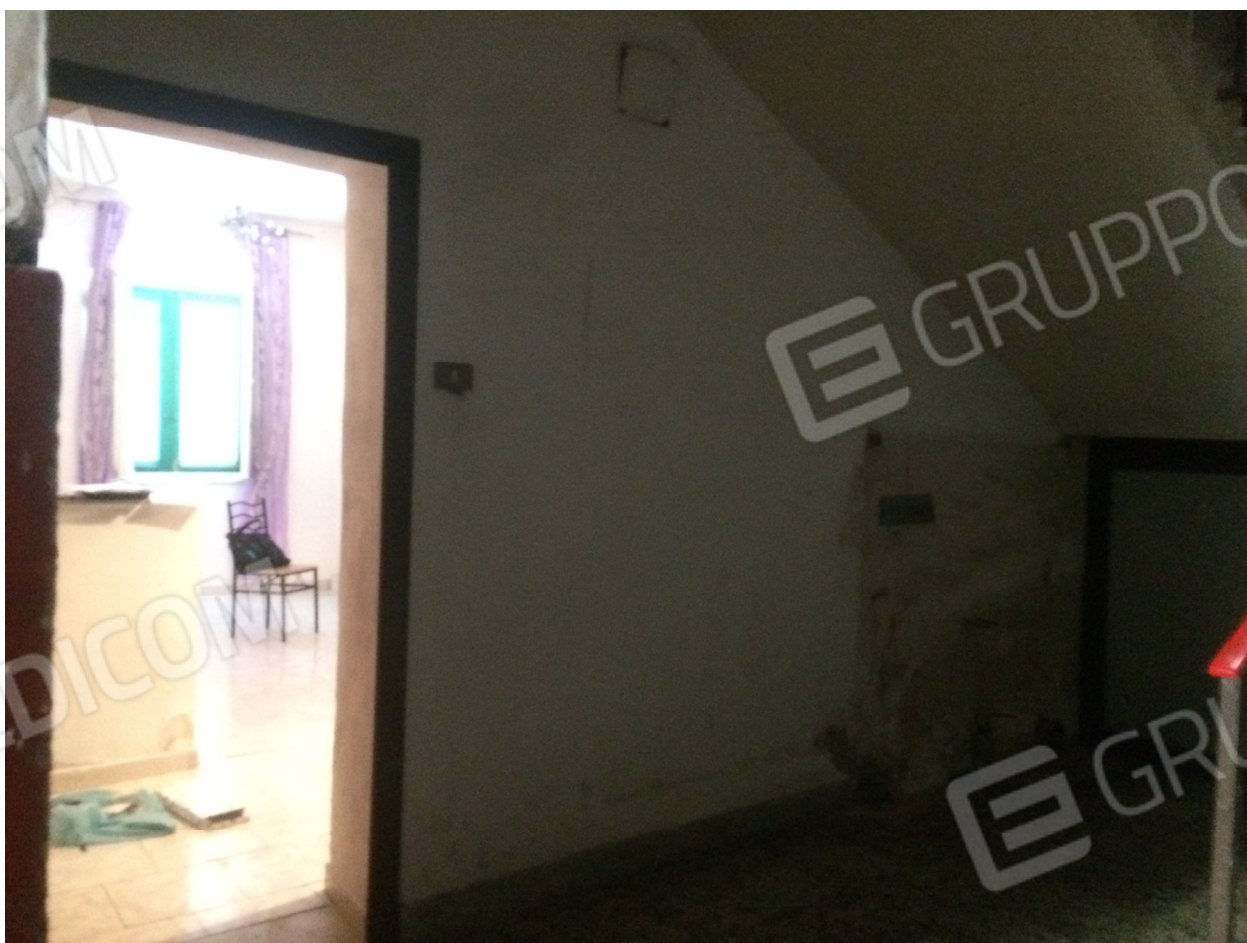
FOTO 6: Pianerottolo e porta di ingresso all'abitazione
