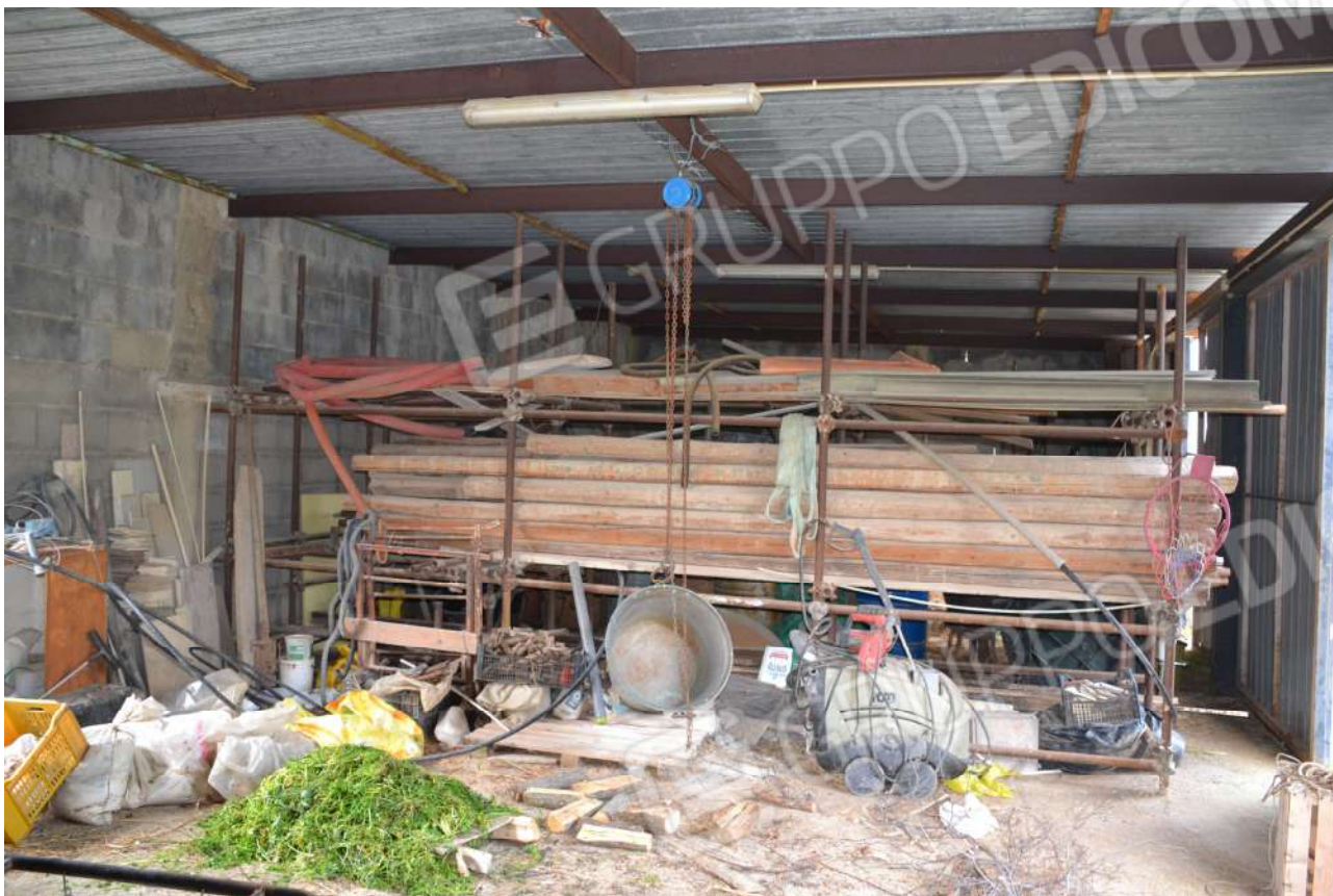
Foto 11 – Altra vista Interna locale deposito di cui alla particella 2386.
