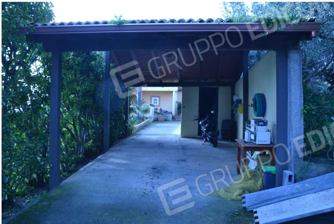
Foto 21 – Tettoia aperta prospetto nord di cui alla particella 2387.
