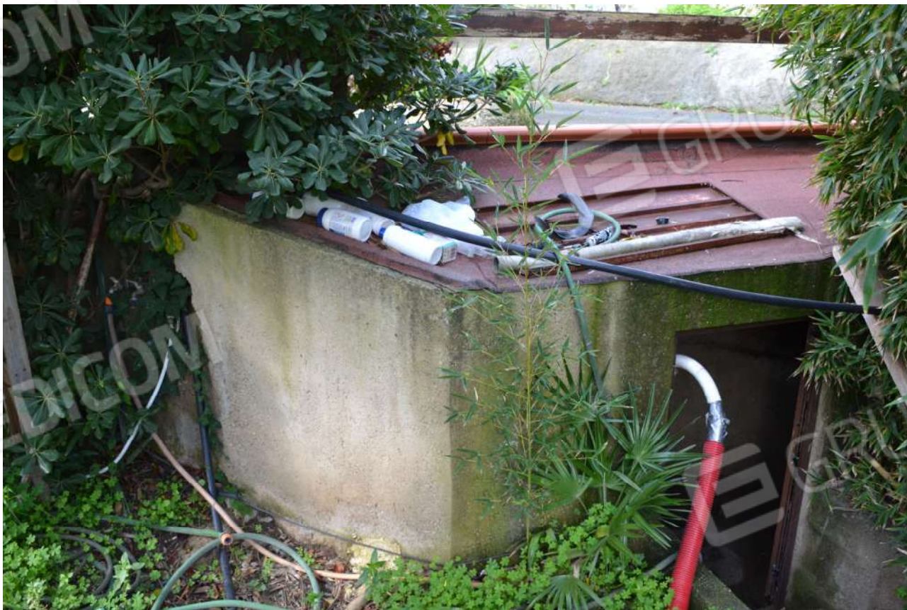
Foto 20 – Locale tecnico di modeste dimensioni a servizio della piscina ricadente nella particella 2385.
