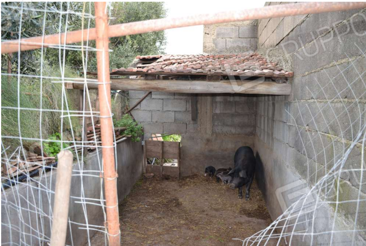
Foto 12 – Porzione esterna del locale deposito coperta per metà.
