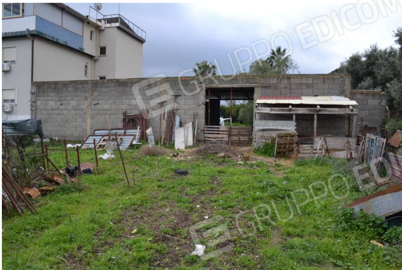
Foto 13 – Prospetto nord locale deposito di cui alla particella 2386.
