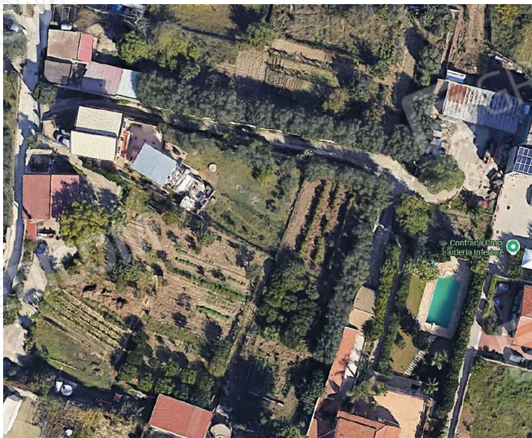
Foto 2 – Veduta aerea, di dettaglio della zona in cui ricadono gli immobili oggetto di stima.
