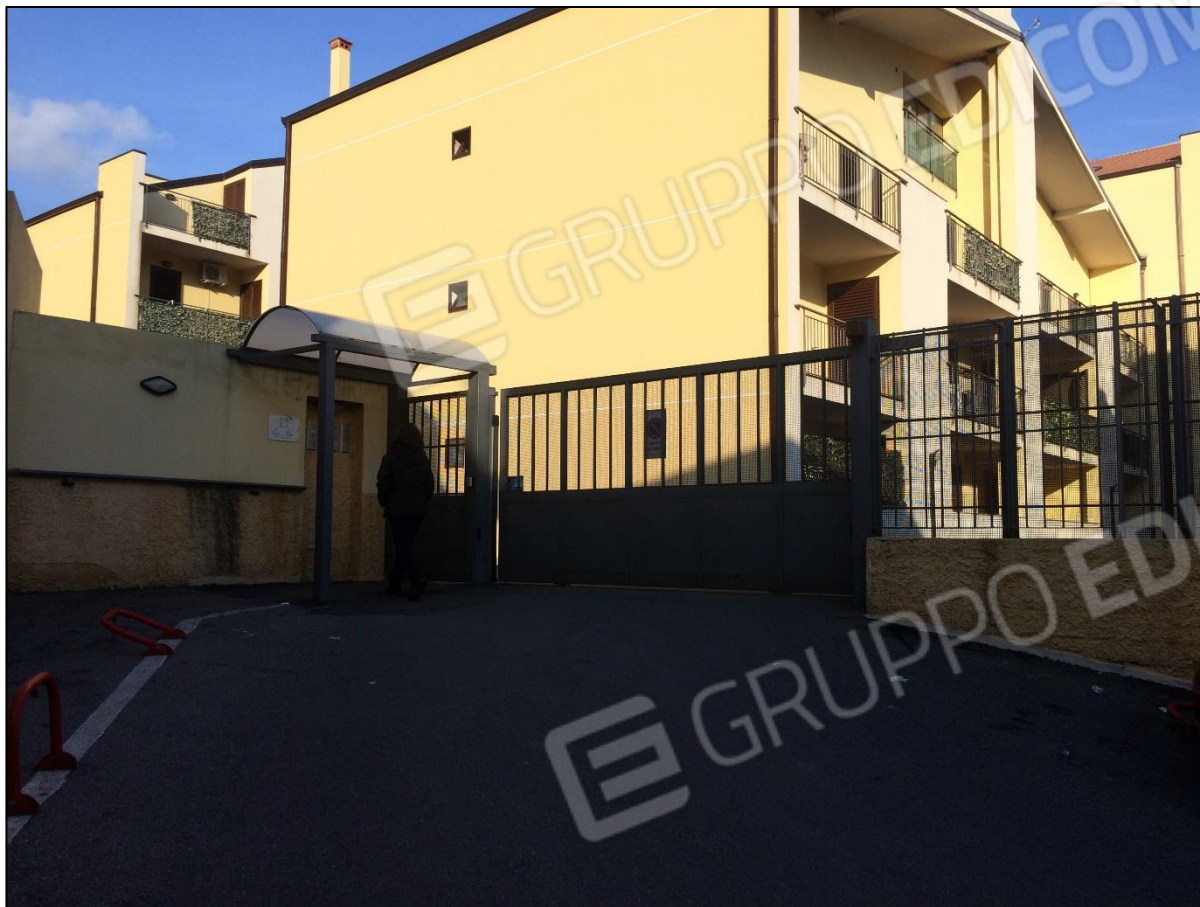
FOTO N. 5: Ingresso carrabile al parcheggio scoperto
