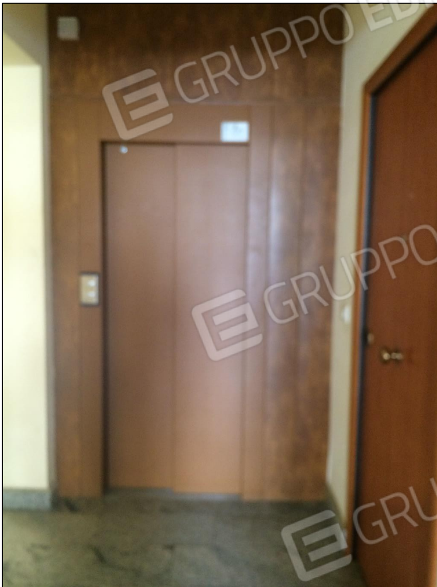
FOTO N. 7: Ascensore Scala A
