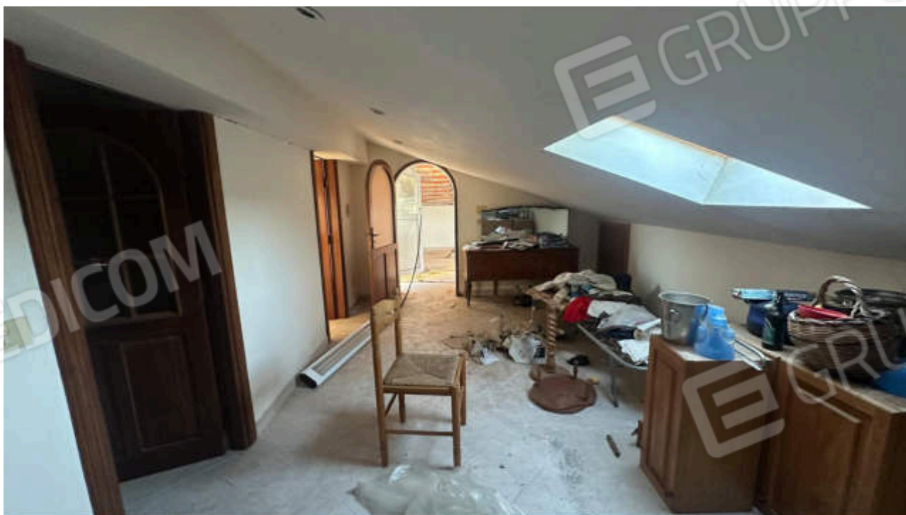
10. Vista 2 su Disimpegno
