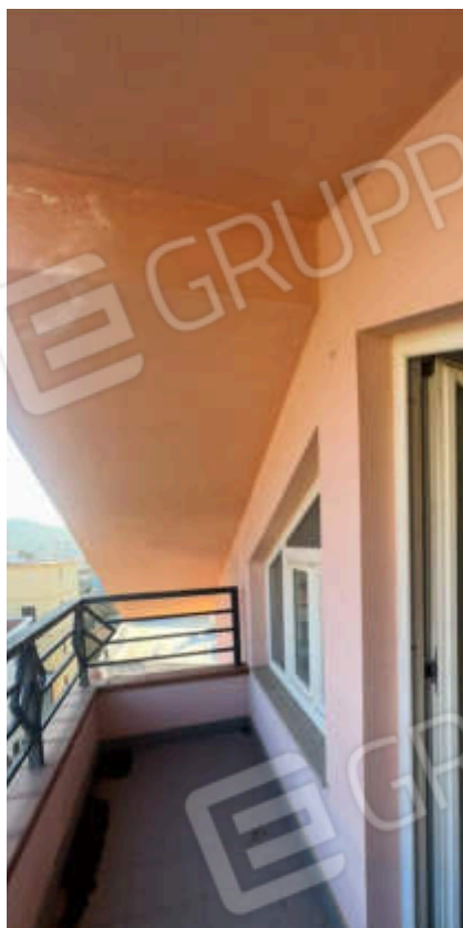
15. Vista 1 su Balcone accessibile dal Locale 8
