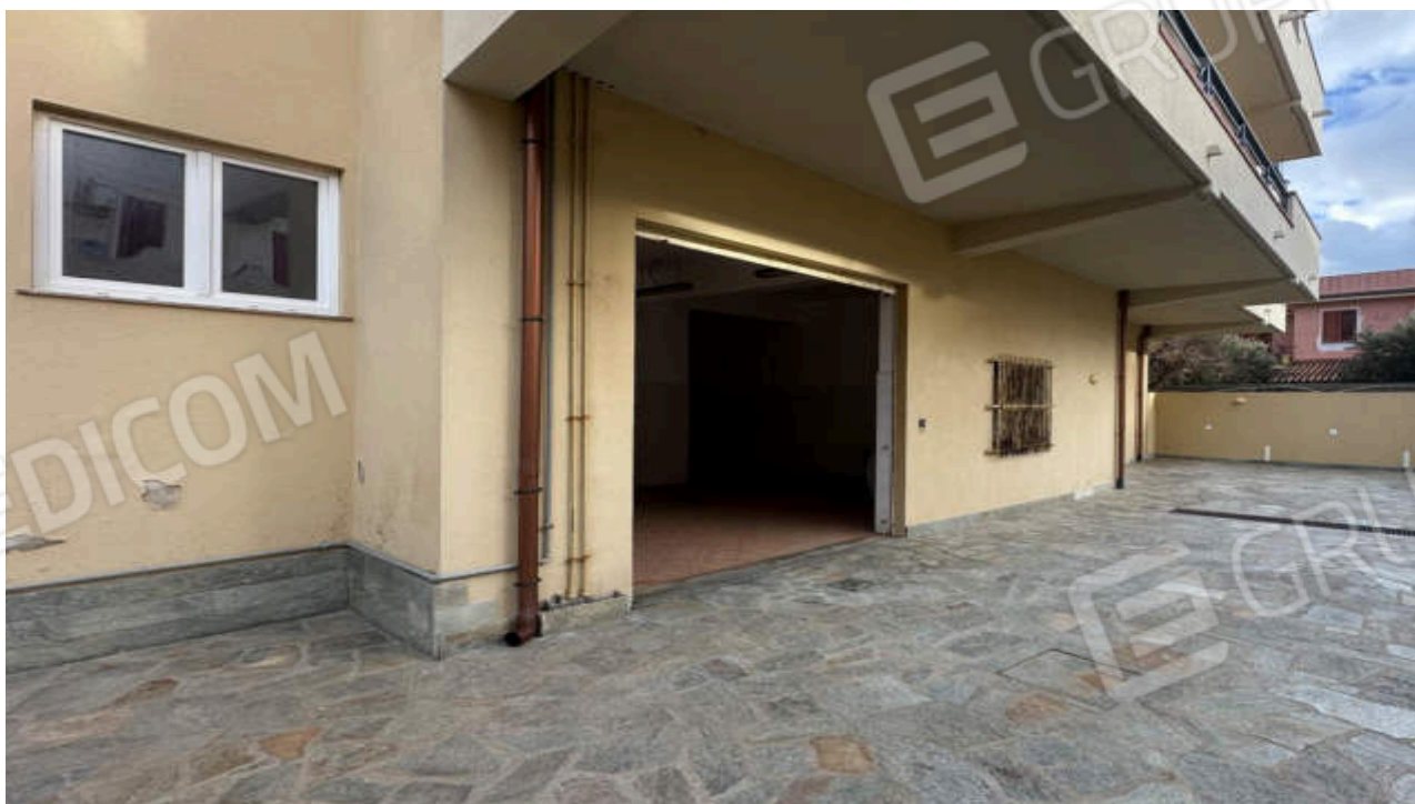
2. Vista su Ingresso Garage
