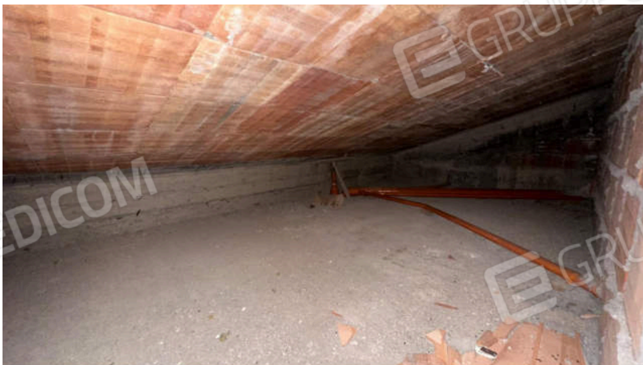
14. Vista su Locale di Sgombero
