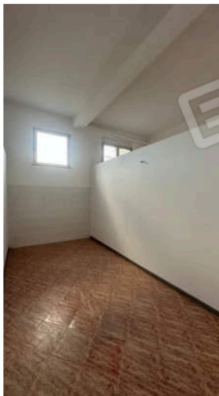
12. Vista 2 su Spogliatoio
