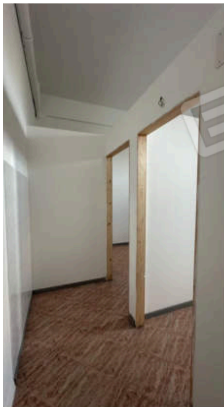
14. Vista 2 su Disimpegno
