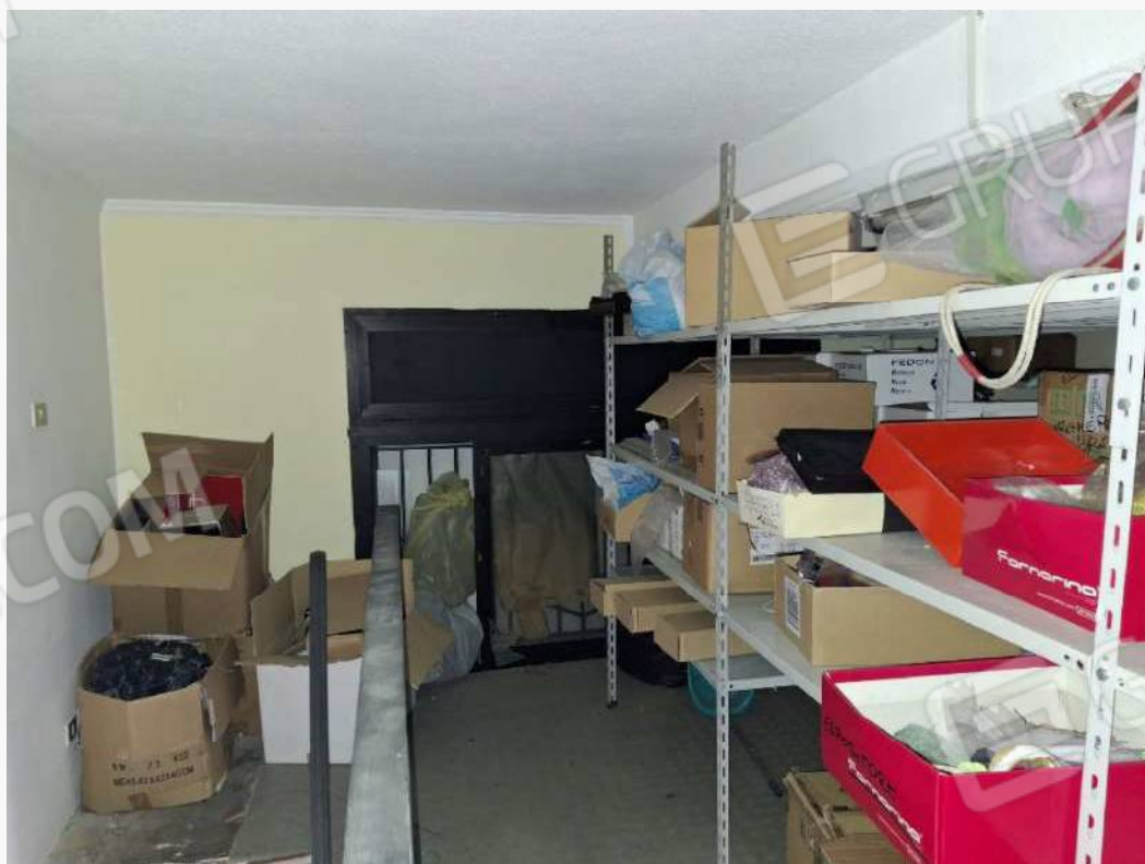
Infisso sovrastante la porta d'ingresso al locale
