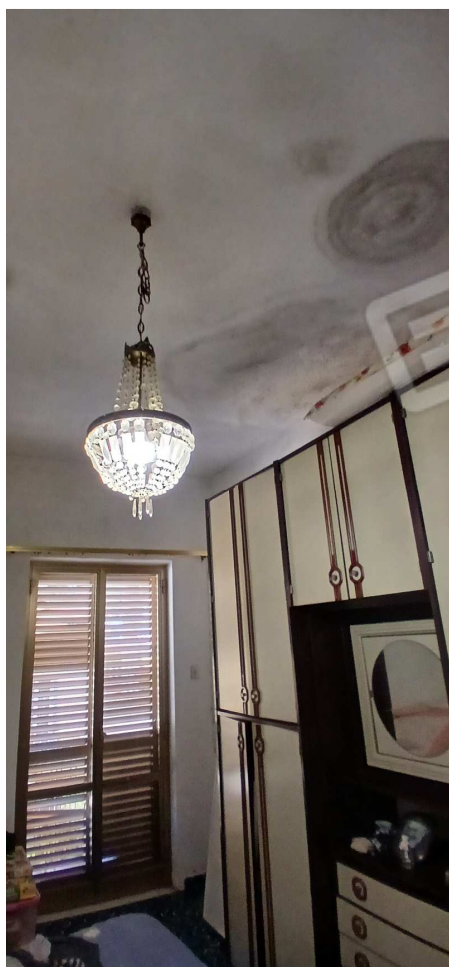
FOTO 13 - 14 - PIANO 1° : CAMERA SOGGETTA AD INFILTRAZIONI A CARICO DEL SOFFITTO
