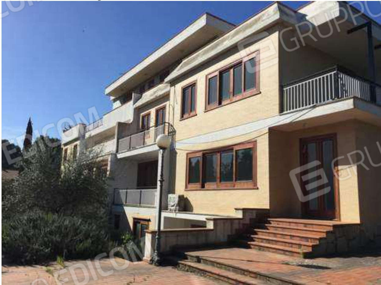
Foto n. 2 : Prospetto laterale della villa quadrifamiliare
