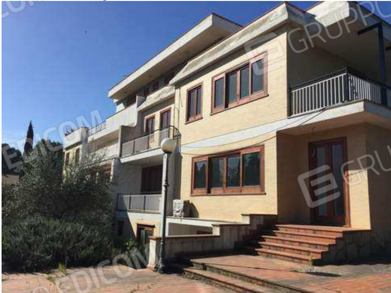
Foto n. 2 : Prospetto laterale della villa quadrifamiliare
