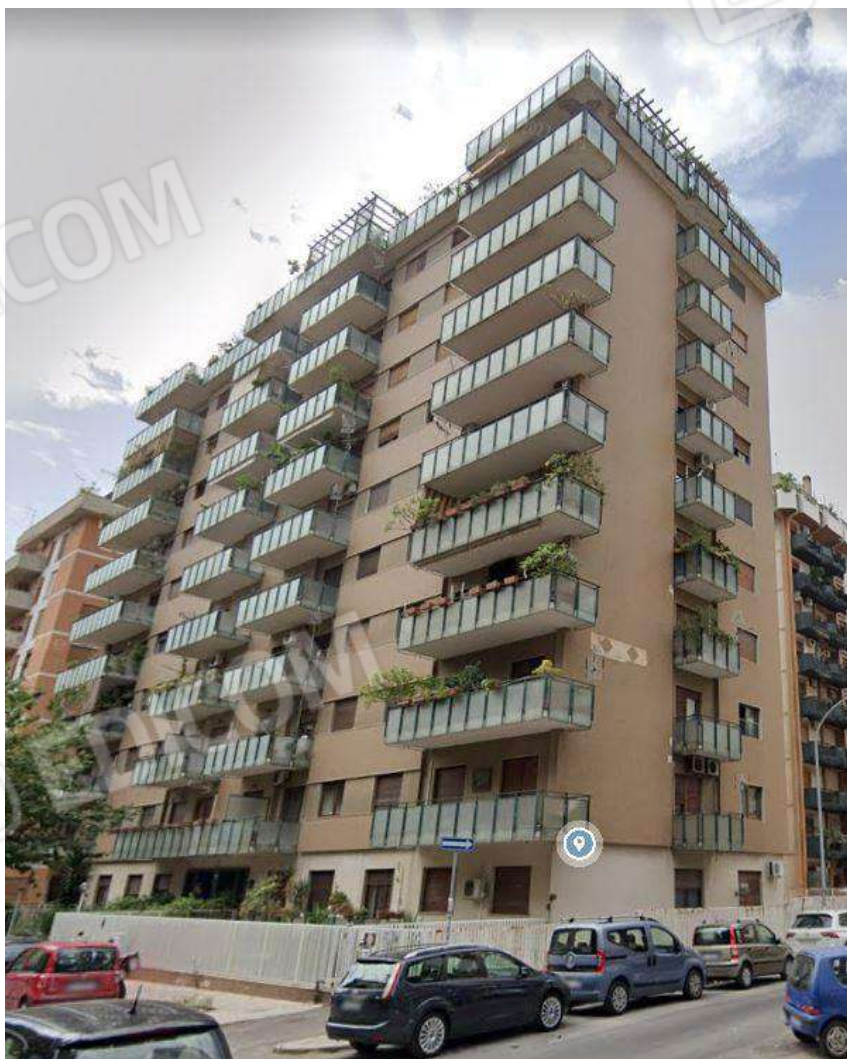
Foto n.1 – Prospetto dell'edificio su via Trinacria
