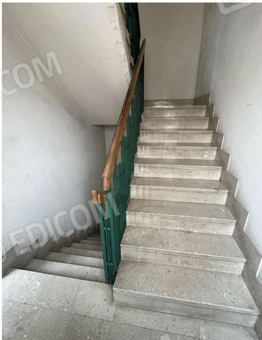
Foto n.3 – Vano scala 1° piano
