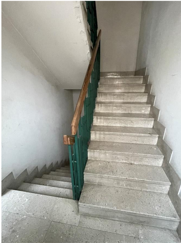
Vano scala "B"
