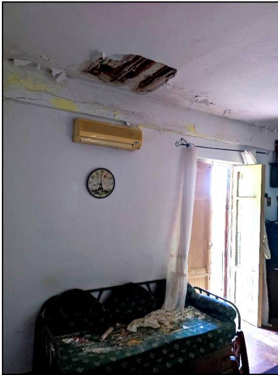
Piano Terra - Intradosso del solaio della Cucina - Pranzo
