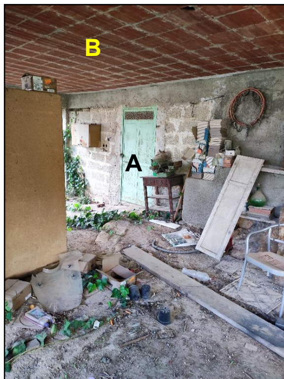
Piano seminterrato: Accesso (A) - intradosso solaio Piano terra(B)
