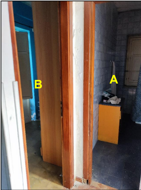
Piano terra : (A) Accesso al WC - (B):Camera da Letto
