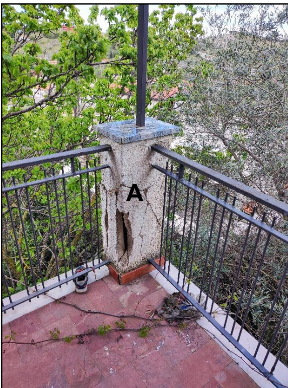
Piano Terra - (A) Part. pila su balcone prospiciente la Cucina
