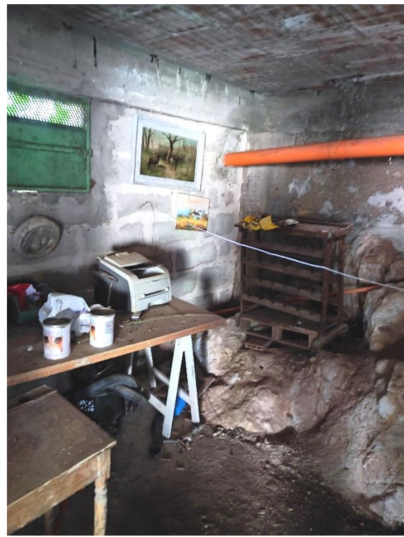
Piano seminterrato: interno deposito
