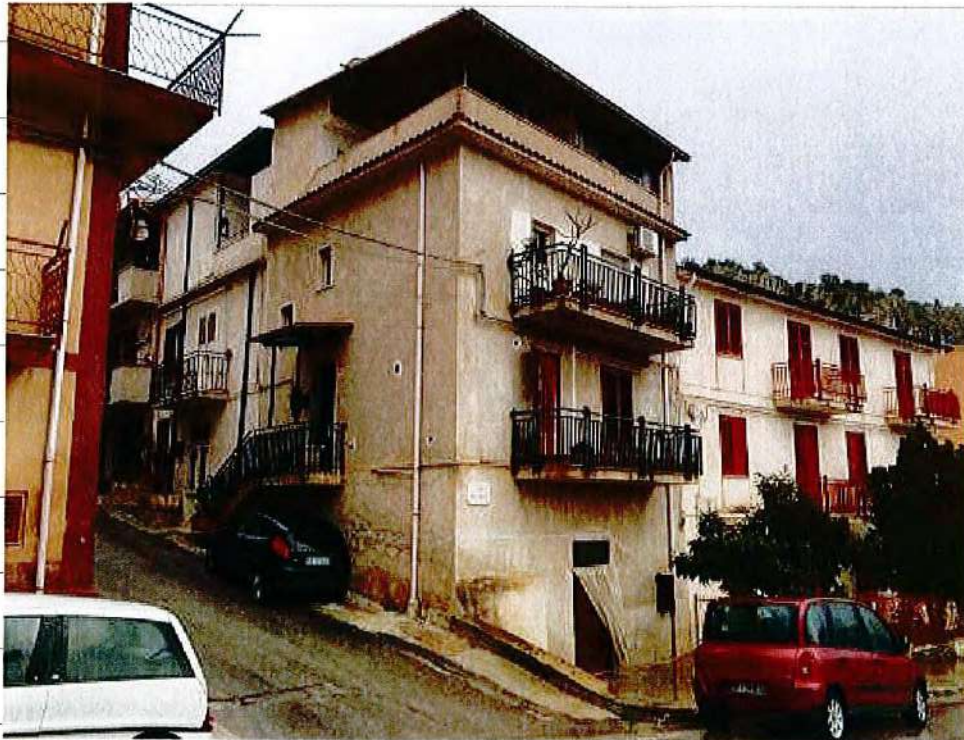
Foto 1: Prospetto esterno principale
