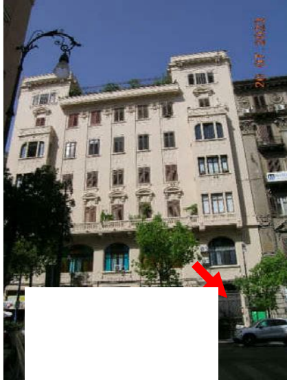
Foto 1 – Edificio via Roma 188 (p.la 122)
