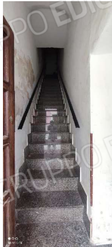
Foto 2- Vista della scala condominiale
