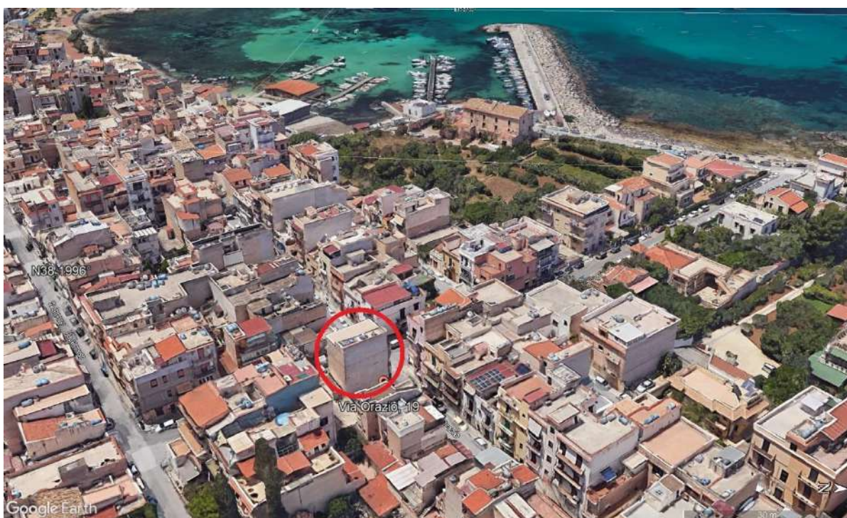
Foto -4- Vista Google dell'edificio di cui fa parte l'U.I. pignorata (vedasi cerchio in rosso)
